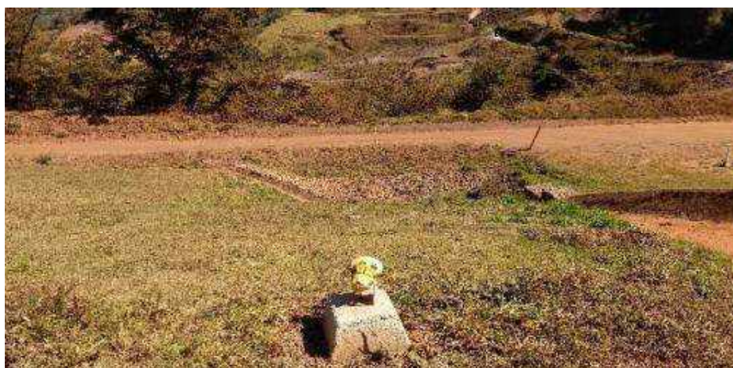
Figura 7 - Instrumentação de controle: Prisma. Fonte: Relatório de Inspeção de Segurança Regular - RISR, do 2º Semestre de 2021 (Relatório 09421-S-BA-RL-01-GE_r1)
