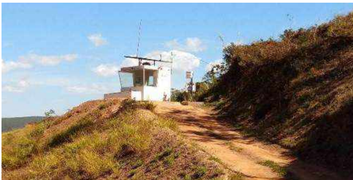
Figura 8 – Estação robótica e radar instalado para acionamento automático das sirenes. Fonte: Relatório de Inspeção de Segurança Regular – RISR, do 2º Semestre de 2021 (Relatório 09421-S-BA-RL-01-GE_r1).
