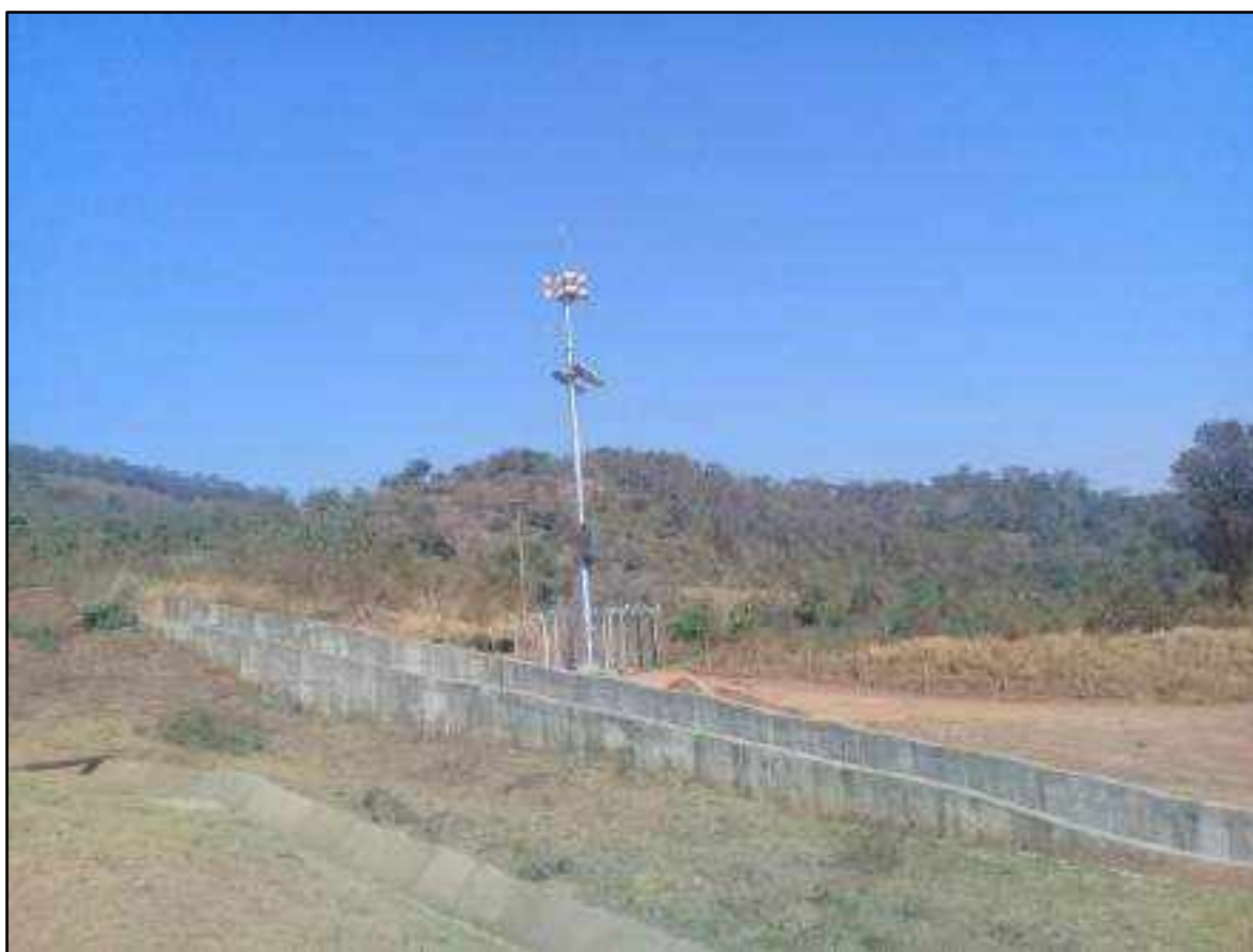
Figura 19 - Torre da Sirene nº1 instalada no campo (ZAS).
