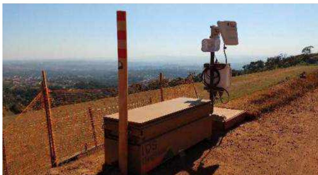
Figura 10 – Instrumentação de Controle – Radar para acionamento automático das sirenes. Fonte: RISR – 2º Semestre de 2021 (09321-S-BA-RL-02-GE_r1).
