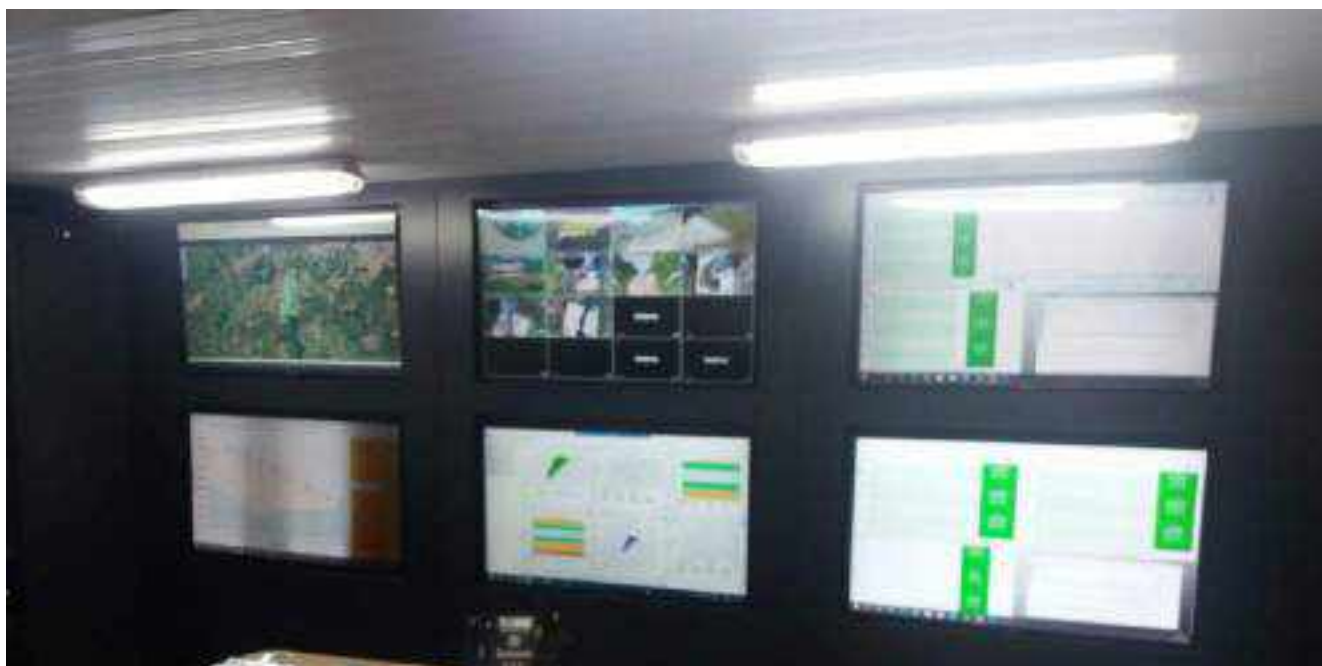
Figura 5 – Imagens dos dados de monitoramento gerados pelo software.
