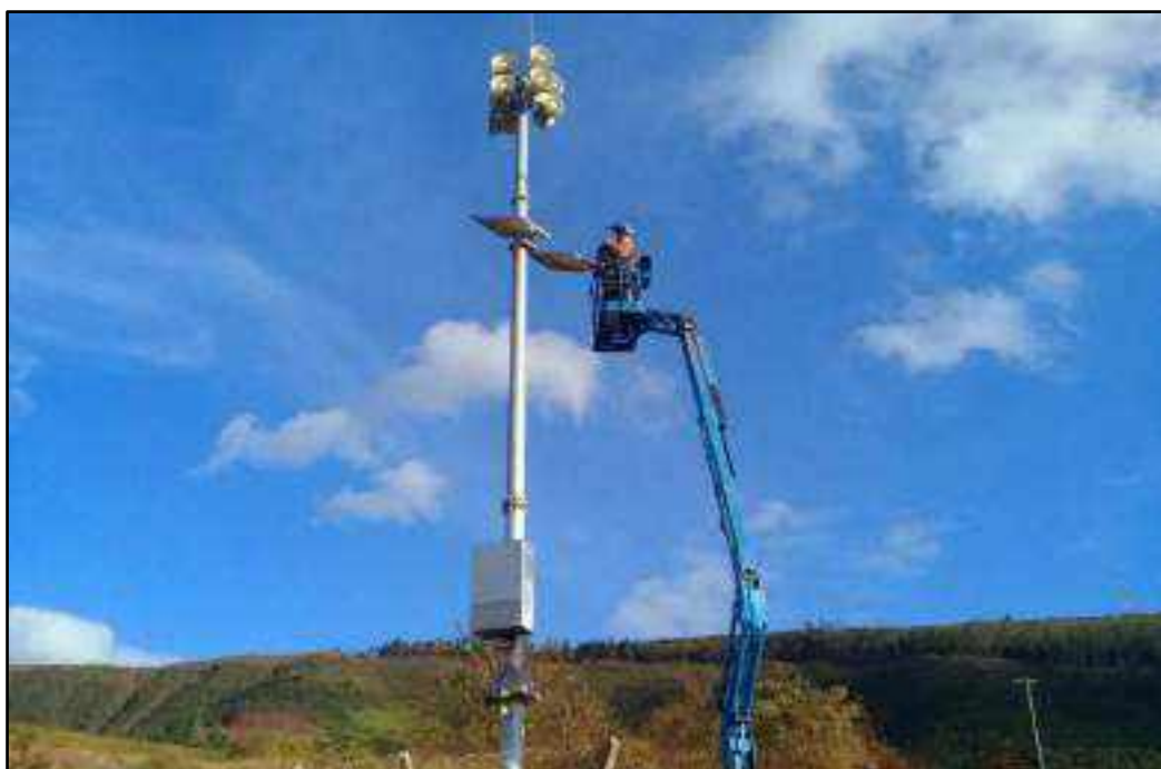
Figura 20 - Manutenção em uma das torres com sirenes instalada no campo (ZAS).
