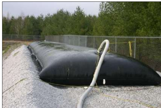
INSERÇÃO 6-7 - Esquema Geobag
