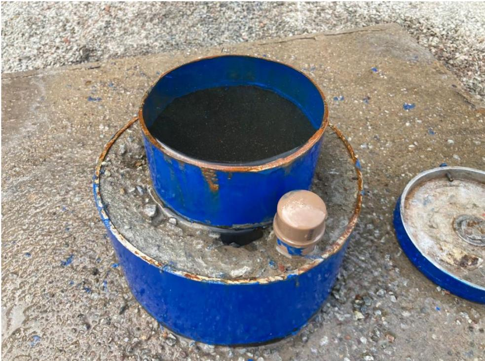
**Figura 12. Boca do poço com tubulão de aço carbono 10 pol. e revestimento interno de 6pol. Verificado artesianismo local, materializando superfície potenciométrica acima da topografia.**
