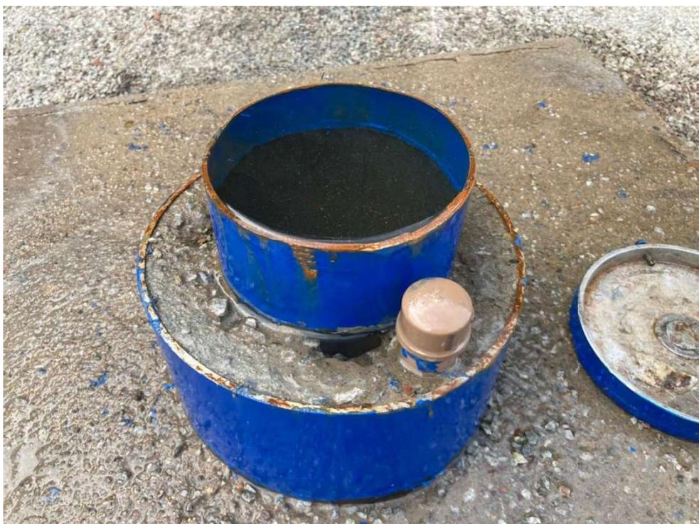
**Figura 13. Boca do poço com tubulão de aço carbono 10 pol. e revestimento interno de 6pol. Verificado artesianismo local, materializando superfície potenciométrica acima da topografia.**
