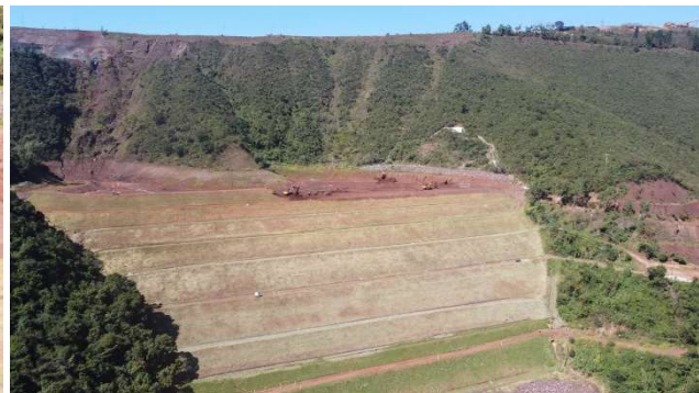
Foto 6.28 – Vista aérea da remoção do maciço do 10º alteamento (11/04/2025).
