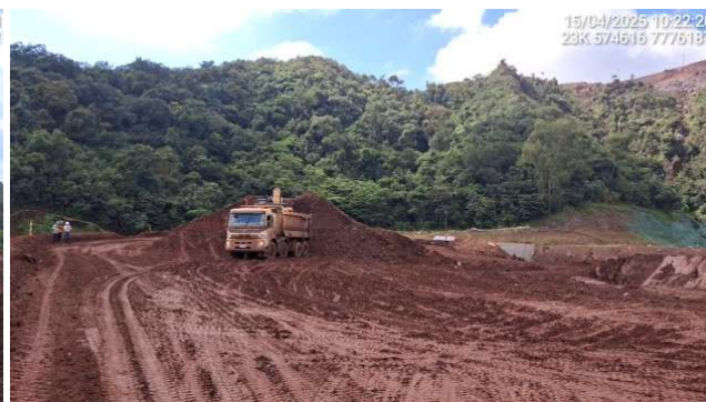
Foto 6.30 – Remoção do maciço do 10º alteamento.
