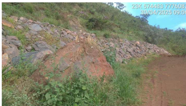
Foto 5.4 – Detalhe da berma de equilíbrio em enrocamento na encosta na margem esquerda.
