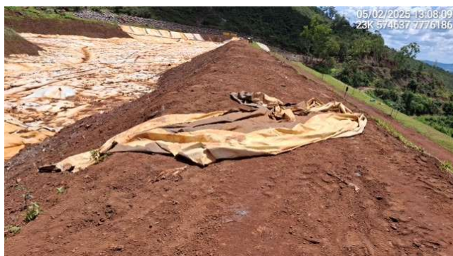
Foto 6.9 – Lona em PEBD removida da face do talude de montante.
