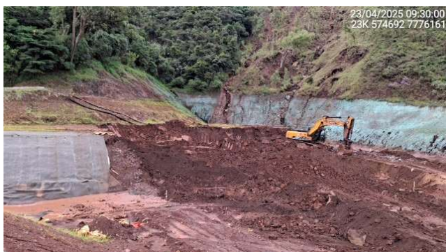
Foto 6.41 – Remoção do rejeito do reservatório.
