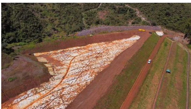
Foto 6.12 – Vista aérea do reservatório após remoção do revestimento do talude de montante.
