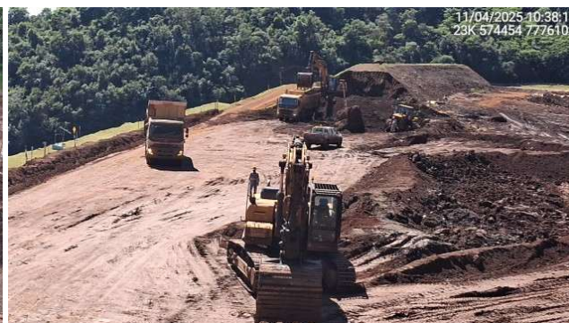
Foto 6.26 – Remoção do maciço do 10º alteamento.
