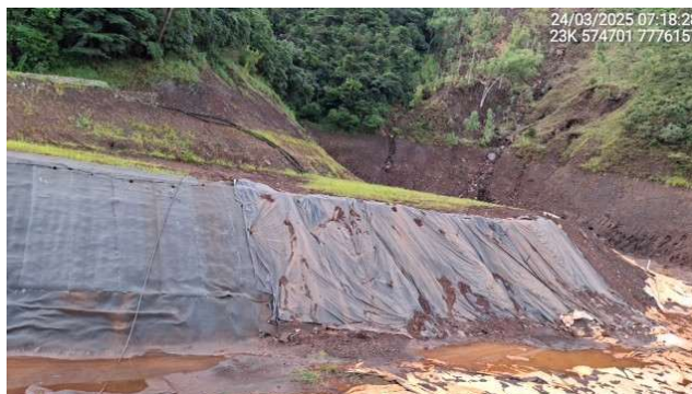
Foto 6.17 – Reparo do revestimento em ponto onde foi verificado o início de processo erosivo.
