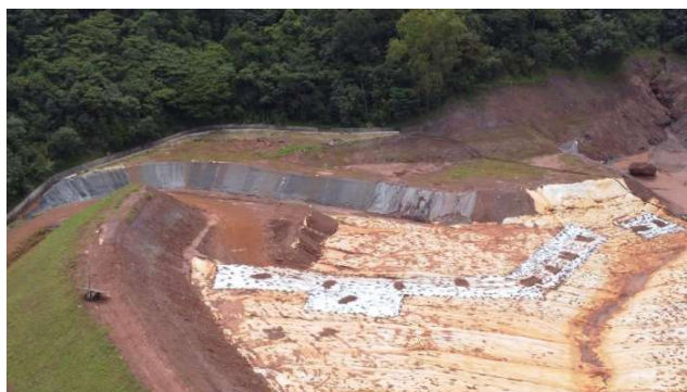
Foto 6.16 – Vista aérea da região em que foi realizado reparo do revestimento do reservatório.
