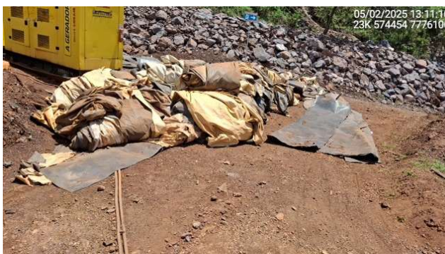
Foto 6.10 – Lona em PEBD removida da face do talude de montante.
