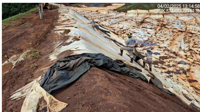
Foto 6.7 – Remoção do revestimento em lona PEBD da face do talude de montante.
