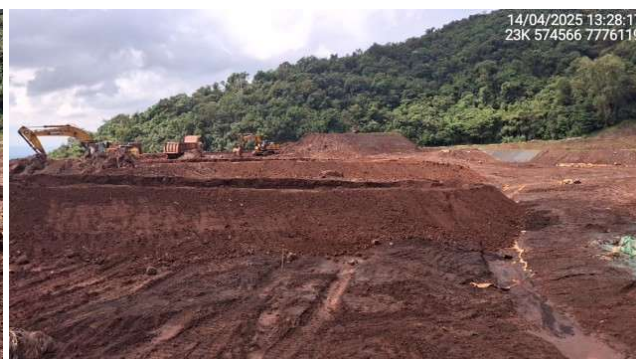
Foto 6.34 – Execução de lastro para acesso de equipamentos ao reservatório.
