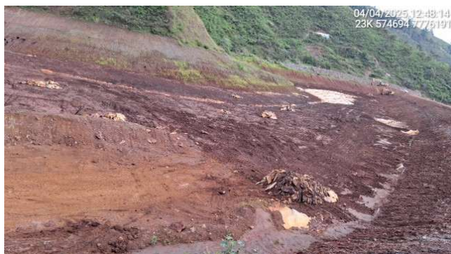
Foto 6.22 – Remoção do revestimento do reservatório.
