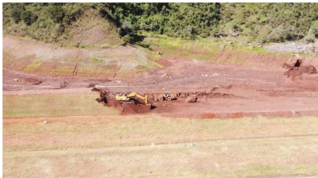
Foto 6.27 – Vista aérea da remoção do maciço do 10º alteamento (11/04/2025).
