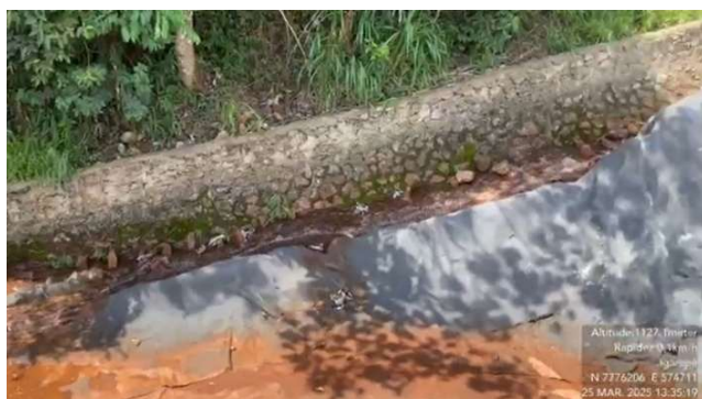
Foto 6.3 – Bombeamento da água acumulada no sump para o canal extravasor.
