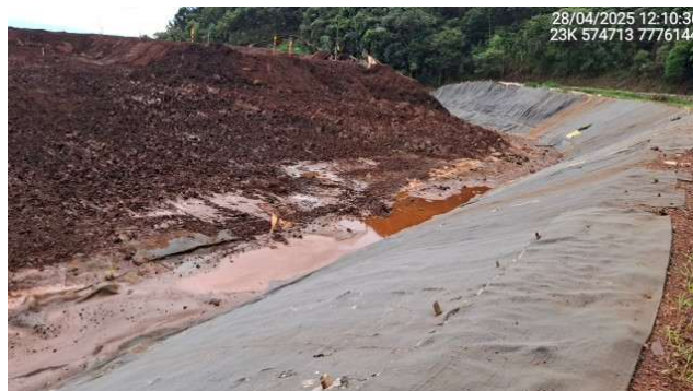
Foto 6.46 – Escavação parcial do canal de conexão do extravasor de emergência.
