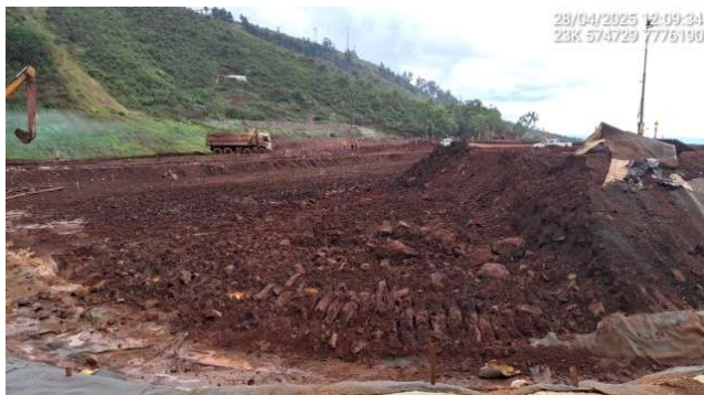
Foto 6.45 – Escavação parcial do canal de conexão do extravasor de emergência.
