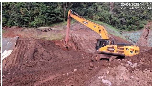
Foto 6.44 – Remoção do rejeito do reservatório.
