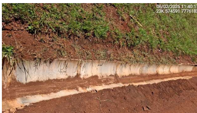
Foto 6.52 – Reparo de trecho da drenagem superficial da berma elev. 1.119,0.
