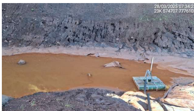
Foto 6.6 – Sump seco após realização do bombeamento.
