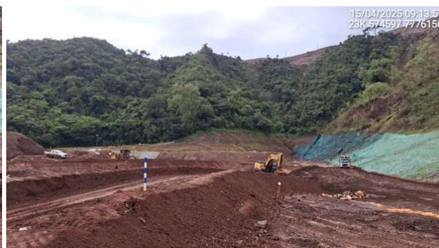
Foto 6.36 – Execução de lastro para acesso de equipamentos ao reservatório.
