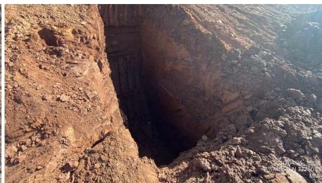
Foto 6.32 – Execução de valas de inspeção em talude escavado no reservatório.
