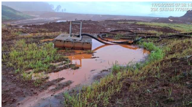
Foto 6.39 – Instalação de bomba para esgotamento da água acumulada no reservatório.
