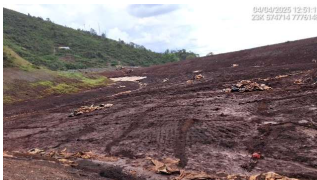
Foto 6.23 – Remoção do revestimento do reservatório.
