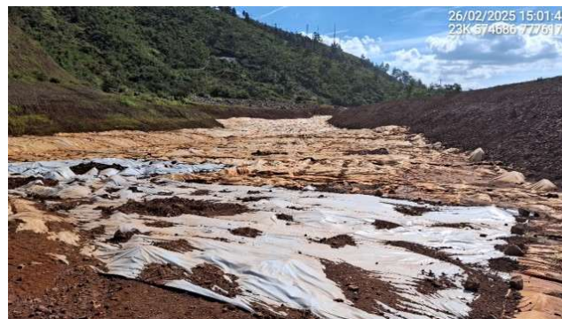
Foto 6.48 – Reparo do revestimento em ponto danificado pelo tráfego de equipamentos.
