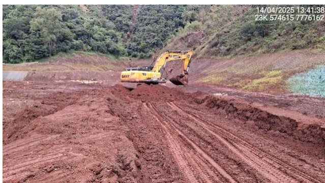
Foto 6.35 – Execução de lastro para acesso de equipamentos ao reservatório.
