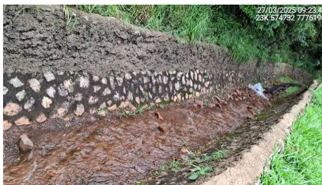
Foto 6.4 – Bombeamento da água acumulada no sump para o canal extravasor.
