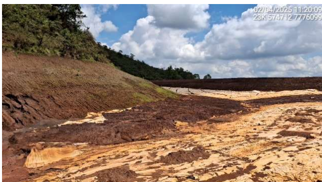
Foto 6.20 – Remoção do revestimento do reservatório.
