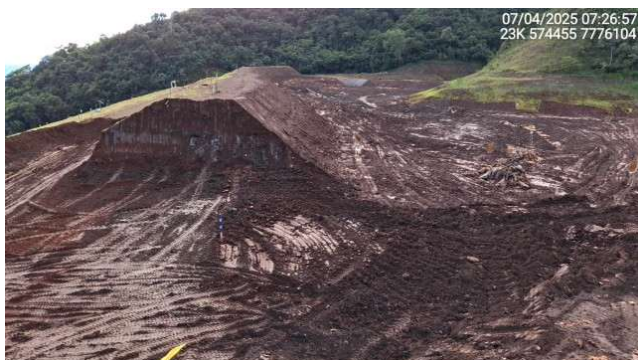
Foto 6.25 – Remoção do maciço do 10º alteamento.
