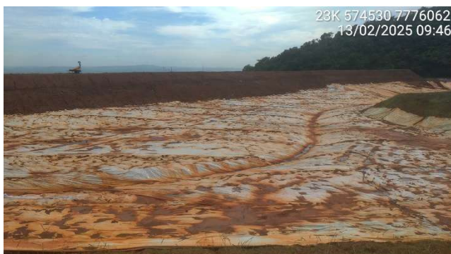
Foto 6.69 – Revestimento do reservatório com lona PEBD.
