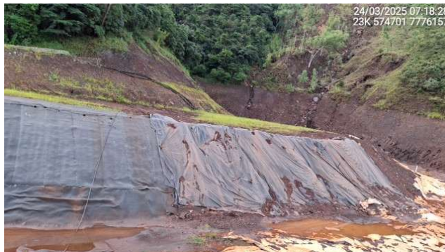
Foto 6.50 – Reparo da proteção na região onde foi identificada erosão na face do talude de montante.
