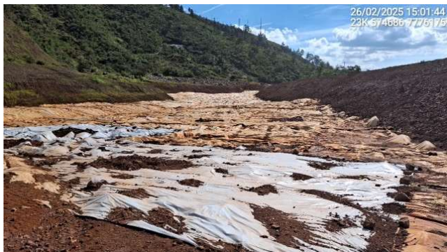
Foto 6.14 – Reparo do revestimento em ponto danificado pelo tráfego de equipamentos.
