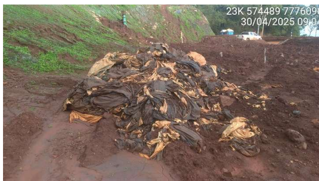
Foto 6.66 – Restos de revestimento em PEBD acumulados dentro do reservatório.
