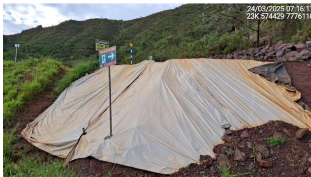
Foto 6.54 – Correção do transpasse na proteção da erosão no talude do acesso à crista da estrutura.
