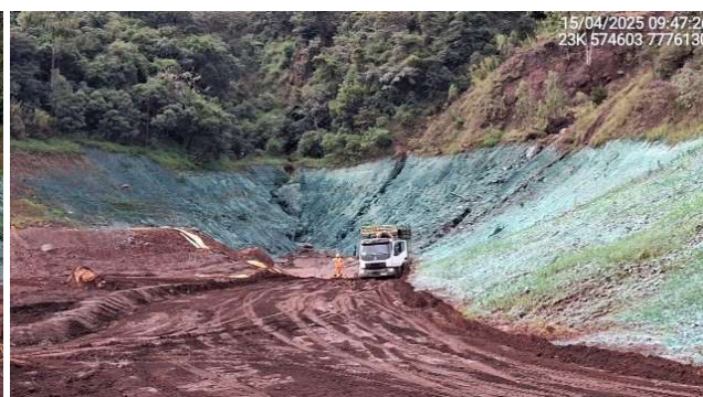
Foto 6.38 – Aplicação de hidrossemeadura em terreno exposto pela escavação do reservatório.
