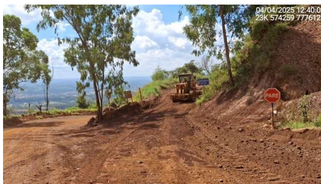
Foto 6.24 – Regularização do acesso à barragem.
