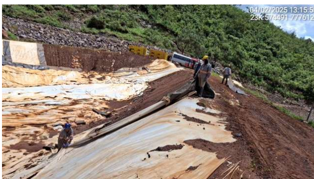
Foto 6.8 – Remoção do revestimento em lona PEBD da face do talude de montante.
