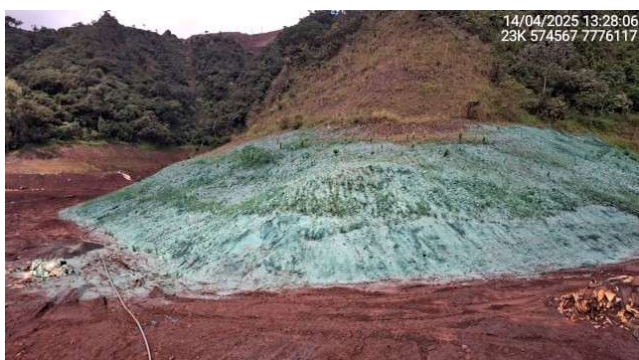
Foto 6.37 – Aplicação de hidrossemeadura em terreno exposto pela escavação do reservatório.
