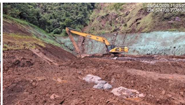
Foto 6.42 – Remoção do rejeito do reservatório.
