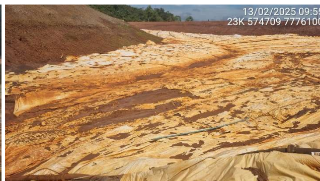
Foto 6.70 – Revestimento do reservatório com lona PEBD.
