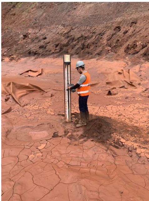
Foto 6.13 – Instalação de régua linimétrica na base do sump do reservatório (Elev.: 1.114,486).
