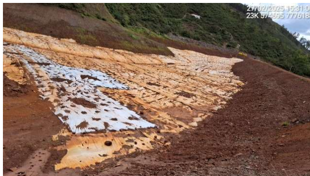
Foto 6.15 – Reparo do revestimento em ponto danificado pelo tráfego de equipamentos.
