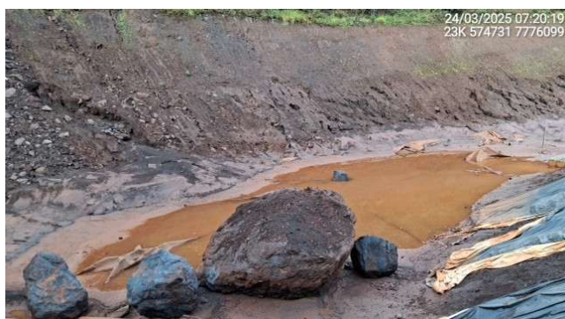
Foto 6.5 – Sump seco após realização do bombeamento.
