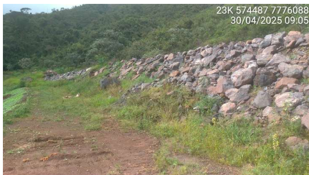
Foto 5.3 – Detalhe da berma de equilíbrio em enrocamento na encosta na margem esquerda.
