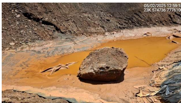
Foto 6.2 – Sump seco após realização do bombeamento.
