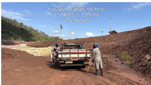
Foto 6.18 – Remoção dos cabos de alimentação do sistema de bombeamento.
