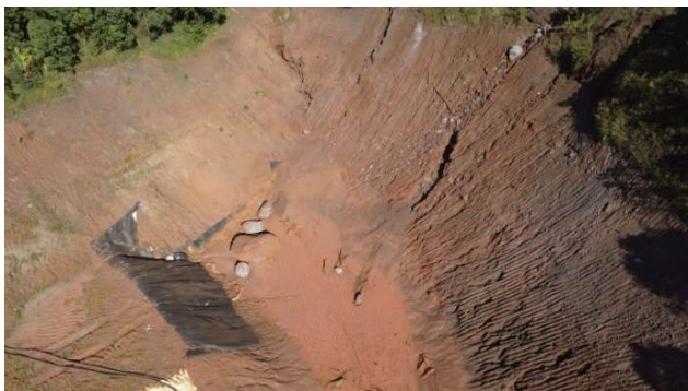
Foto 6.56 – Vista aérea do sump com destaque para os blocos rolados provenientes da encosta.
