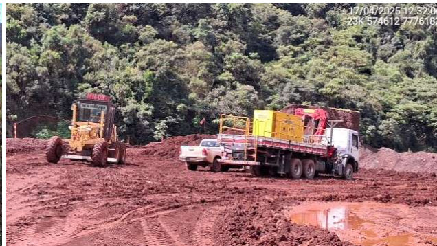
Foto 6.40 – Instalação de gerador para acionamento do sistema de bombeamento.
