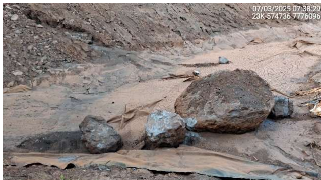
Foto 6.55 – Blocos rolados para dentro do sump provenientes da encosta.
