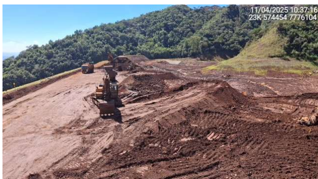
Foto 6.33 – Execução de lastro para acesso de equipamentos ao reservatório.
