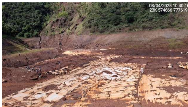
Foto 6.21 – Remoção do revestimento do reservatório.
