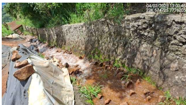
Foto 6.1 – Bombeamento da água acumulada no sump para o canal extravasor.
