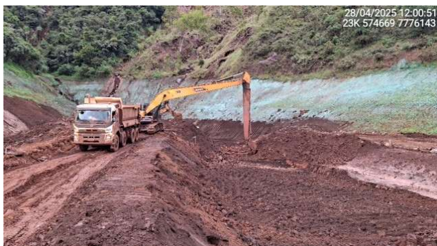
Foto 6.43 – Remoção do rejeito do reservatório.
