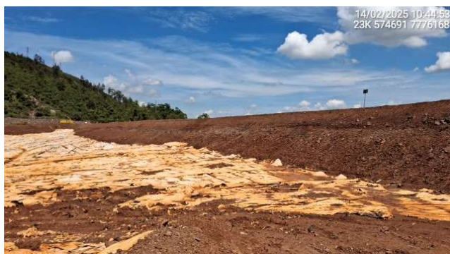
Foto 6.11 – Talude de montante após remoção do revestimento em PEBD.
