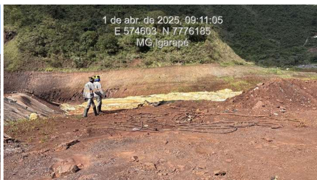
Foto 6.19 – Remoção dos cabos de alimentação do sistema de bombeamento.
