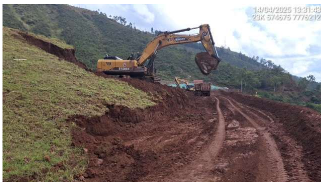
Foto 6.29 – Remoção do maciço do 10º alteamento.
