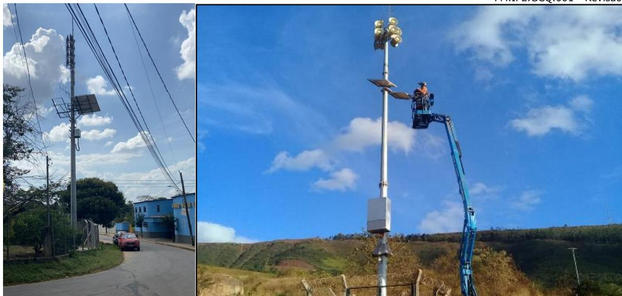
**Figura 6 – Torre da Sirene instalada no perímetro urbano (esquerda), e exemplo de manutenção em uma das torres com sirene (direita).**
