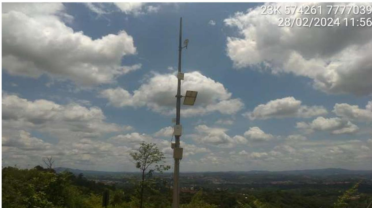
**Figura 20 – Radar instalado para acionamento automático das sirenes em emergência nível 3.**
