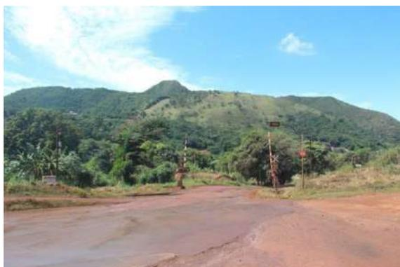
Foto 3-9: Trecho final da estrada pavimentada, no cruzamento com a estrada de ferro, após esse cruzamento, a estrada passa a ser sem pavimentação.
