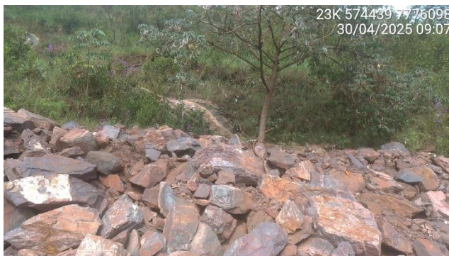
Foto 5-2 – Dispositivos de drenagem superficial no contato da cunha de ruptura com o terreno natural, na margem esquerda.
