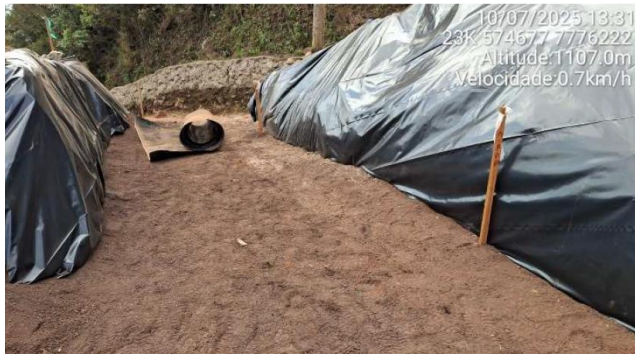
Foto 6-37 - Instalação de lonas nas paredes do canal de conexão, após ajustes na seção do canal.
