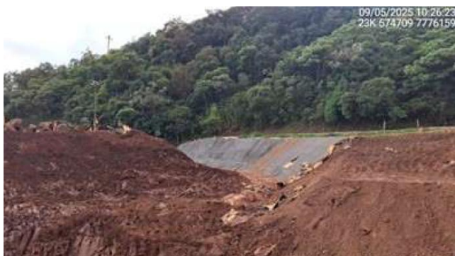
Foto 6-7 - Escavação parcial do canal de conexão do extravasor de emergência.
