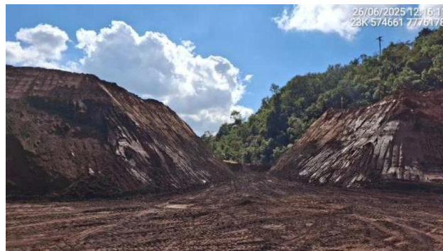
Foto 6-26 - Remoção parcial do maciço do 9º alteamento.
