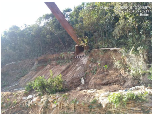
Foto 5-8 - Remoção do material solto e conformação da encosta na Ombreira Direita
