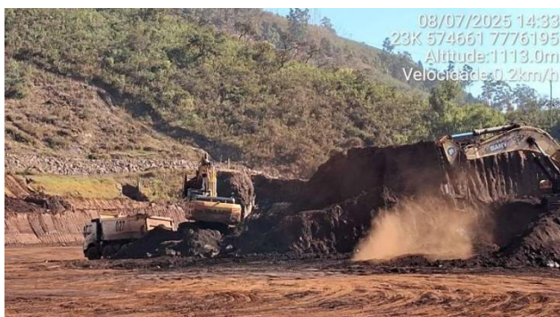
Foto 6-27 - Remoção do maciço do 9º alteamento Etapa 1 – Fase 3B.
