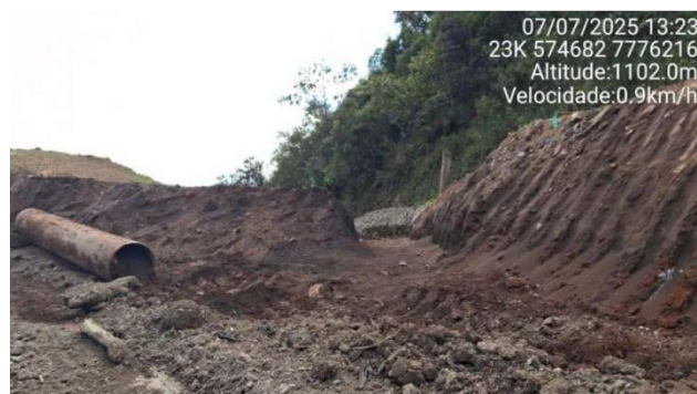
Foto 6-33 - Execução do canal de conexão do extravasor de emergência – Etapa 1 – Fase 3.
