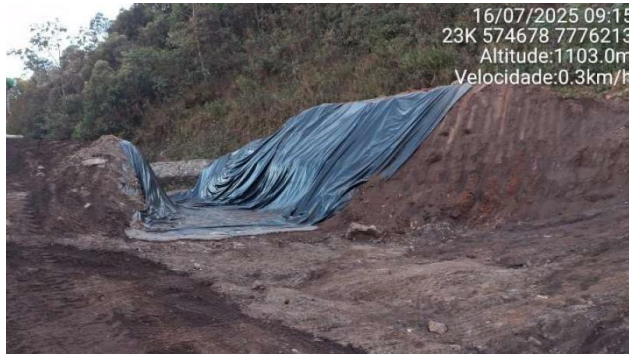
Foto 6-38 - Instalação de lonas nas paredes do canal de conexão, após ajustes na seção do canal.
