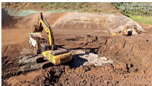
Foto 6-1 - Remoção do rejeito do reservatório.
