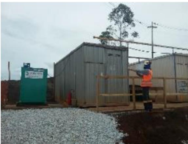
Foto 6-48 – Monitoramento em equipamento com escada.
