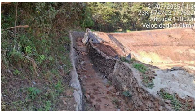
Foto 6-42 - Reconstituição de trecho do canal periférico no desemboque do antigo canal de conexão da Etapa 1 – Fase 2
