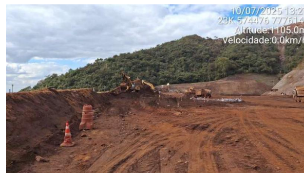
Foto 6-28 - Remoção do maciço do 9º alteamento Etapa 1 – Fase 3B.
