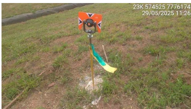
Foto 6-9 - Instalação prismas de deslocamento
