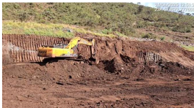
Foto 6-24 - Remoção do rejeito do reservatório no contato com a encosta na região da ombreira esquerda.
