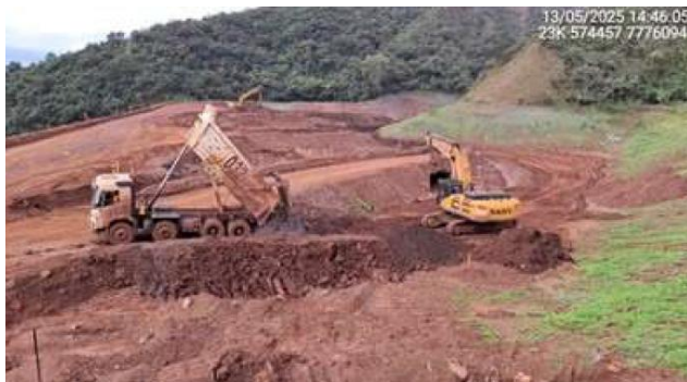
Foto 6-13 - Execução de lastro para acesso de equipamentos ao reservatório.
