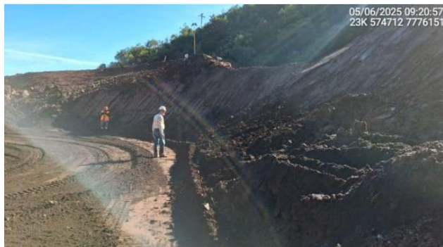
Foto 6-19 - Inspeção na remoção do rejeito no contato com a ombreira direita.
