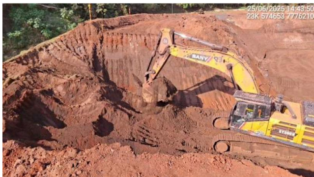
Foto 6-25 - Remoção parcial do maciço do 9º alteamento.
