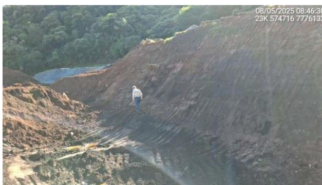
Foto 6-6 - Inspeção do talude próximo ao canal de conexão.
