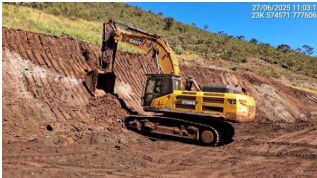
Foto 6-32 - Execução de valas de inspeção próximo à encosta da ombreira esquerda.
