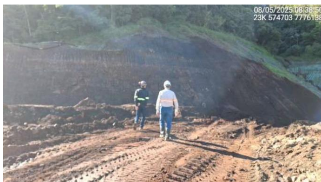
Foto 6-5 - Inspeção do talude próximo ao canal de conexão.
