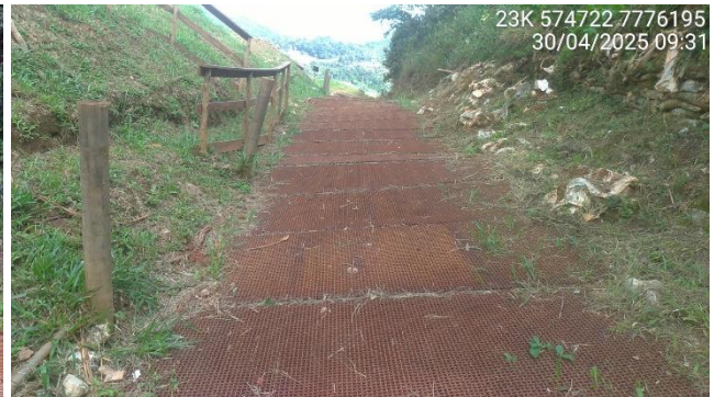
Foto 5-7 – Grades metálicas instaladas sobre o canal extravasor de emergência.
