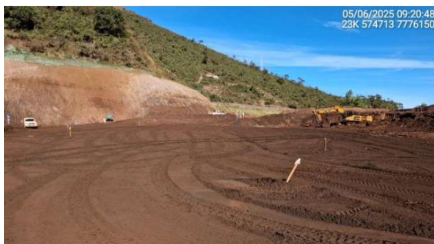
Foto 6-17 - Regularização do reservatório.
