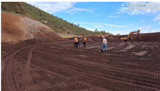
Foto 6-20 - Inspeção na remoção do rejeito na encosta a montante do reservatório.
