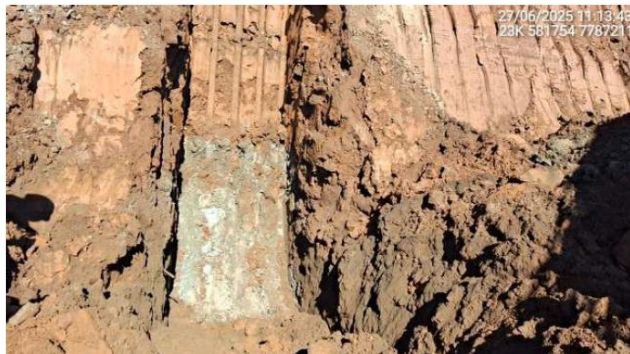
Foto 6-31 - Execução de valas de inspeção próximo à encosta da ombreira esquerda.
