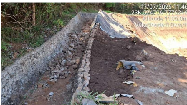
Foto 6-41 - Reconstituição de trecho do canal periférico no desemboque do antigo canal de conexão da Etapa 1 – Fase 2
