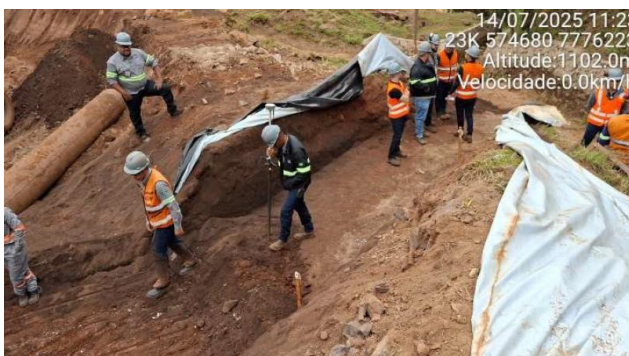
Foto 6-34 - Implantação de ajuste na seção do canal de conexão – Etapa 1 – Fase 3.
