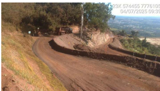
Foto 6-29 - Execução de acesso operacional conectando à berma elev. 1.114,00.
