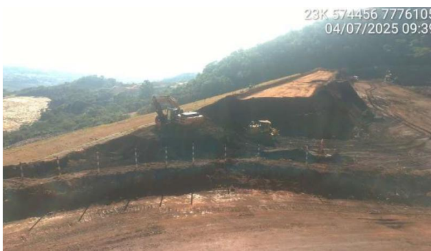
Foto 6-30 - Execução de acesso operacional conectando à berma elev. 1.114,00.
