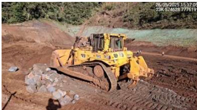
Foto 6-14 - Execução de lastro para acesso de equipamentos ao reservatório.
