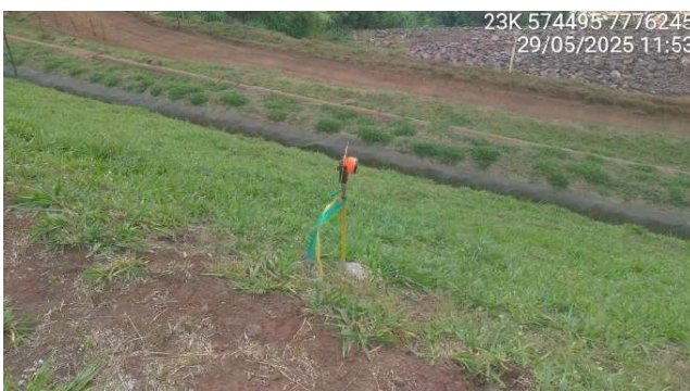
Foto 6-10 - Instalação prismas de deslocamento
