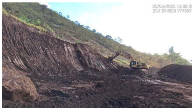
Foto 6-23 - Remoção do rejeito do reservatório no contato com a encosta na região da ombreira esquerda.
