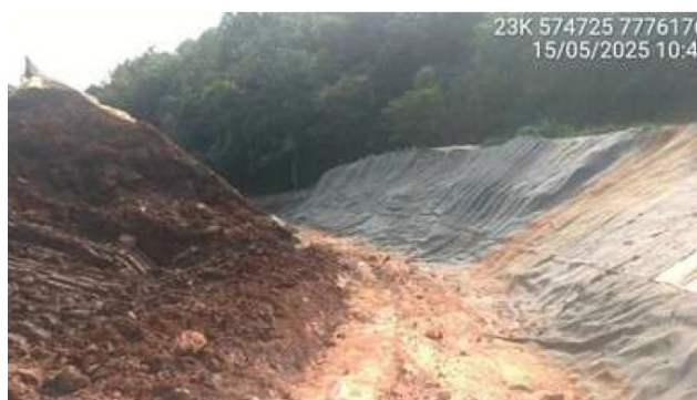
Foto 6-8 - Escavação parcial do canal de conexão do extravasor de emergência.
