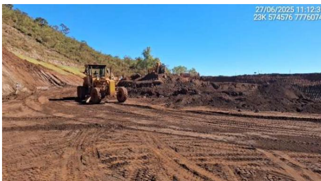
Foto 6-18 - Regularização do reservatório.
