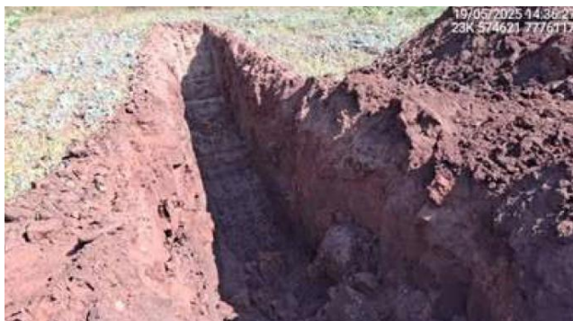
Foto 6-11 - Vala de inspeção realizada no talude de montante do reservatório.
