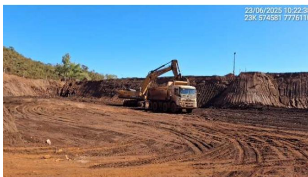
Foto 6-2 - Remoção do rejeito do reservatório.
