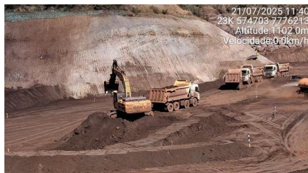
Foto 6-3 - Remoção do rejeito do reservatório - Etapa 1 – Fase 4A.
