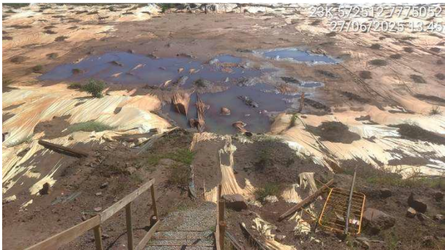
Foto 5-6 – Sistema de bombeamento que estava instalado na baía de jusante foi removido.
