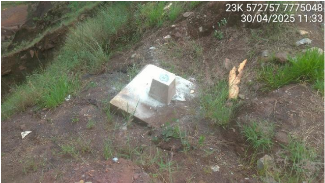
Foto 5-8 – Marco de deslocamento instalado na encosta.
