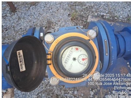
Foto 5-1 – Vista do poço de bombeamento PT-01.
