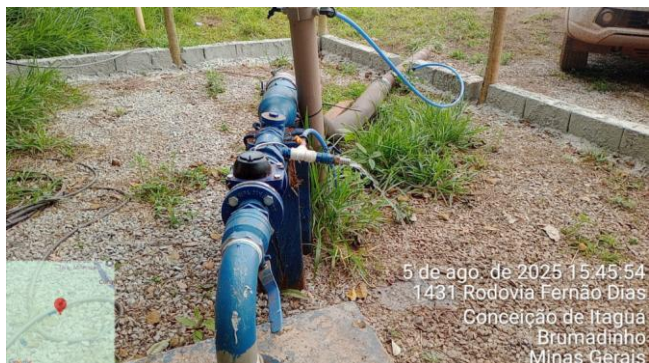
Foto 5-3 – Vista do poço – PT-02.
