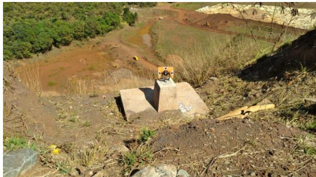
Foto 5-10 - Prisma de monitoramento na encosta
