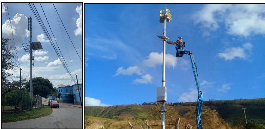
Figura 10 – Torre da Sirene instalada no perímetro urbano (esquerda), e exemplo de manutenção em uma das torres com sirene (direita).
