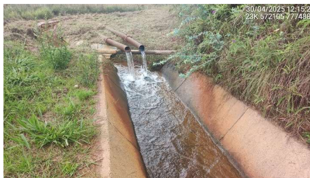
Foto 5.4 – Vista do direcionamento do fluxo dos poços para o extravasor da Barragem B1A Emicon.
