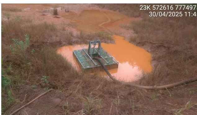
Foto 5.7 – Sistema de bombeamento localizado na baía de montante.
