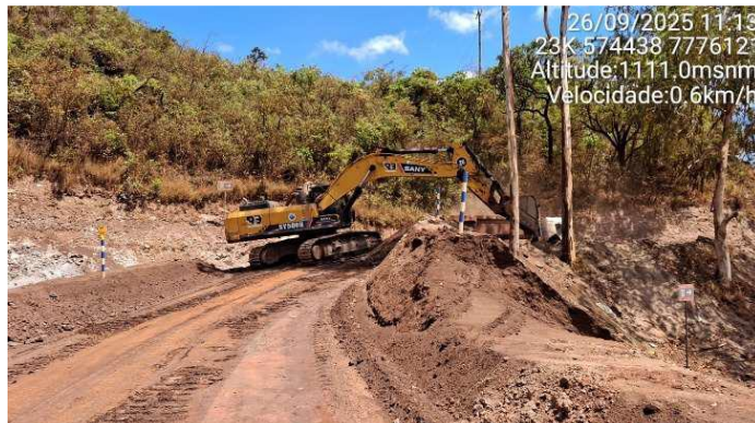
Foto 6-19 - Rebaixamento do acesso ao reservatório na região da ombreira esquerda.
