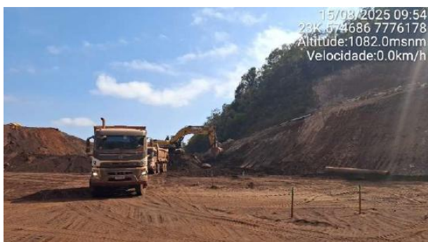
Foto 6-5 - Execução do canal de aproximação do extravasor de emergência – Etapa 1 – Fase 4B.
