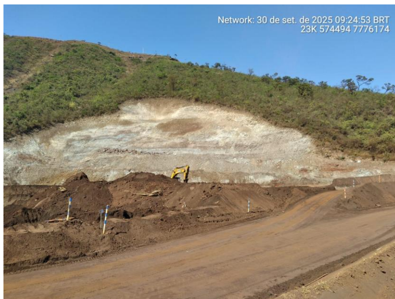
Foto 5-6 - Ombreira Esquerda regularizada com material superficial removido
