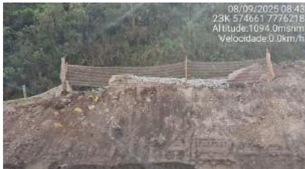
Foto 6-13 - Reconstituição da parede do canal de contorno em pedra argamassada.
