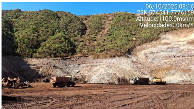
Foto 6-3 - Remoção do rejeito do reservatório – Etapa 1 – Fase 4A.
