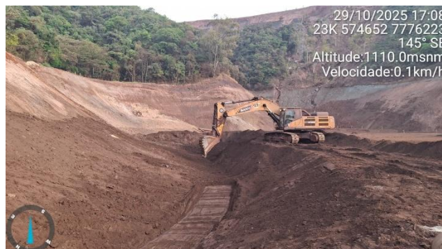
Foto 6.33 – Rebaixamento do canal de conexão ao extravasor de emergência.
