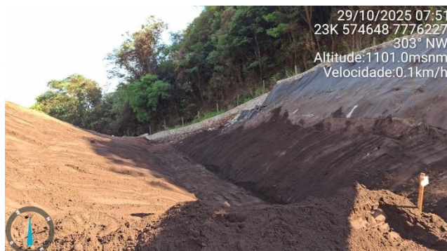
Foto 6.32 – Rebaixamento do canal de conexão ao extravasor de emergência.
