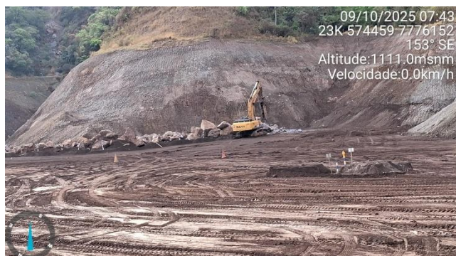
Foto 6.20 - Cominuição de blocos na região dos talvegues próximos à margem esquerda.
