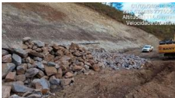
Foto 6-11 - Cominuição de blocos na encosta natural próxima à margem esquerda.
