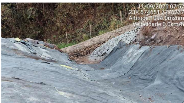
Foto 6-15 - Aplicação de manta cimentícia em parte do canal de aproximação.
