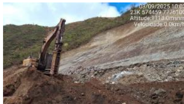
Foto 6-12 - Cominuição de blocos na encosta natural próxima à margem esquerda.
