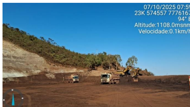
Foto 6-8 - Remoção do maciço do 8º alteamento – Etapa 1 – Fase 4B.
