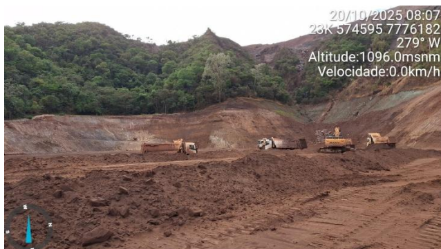
Foto 6.26 – Escavações complementares no reservatório.
