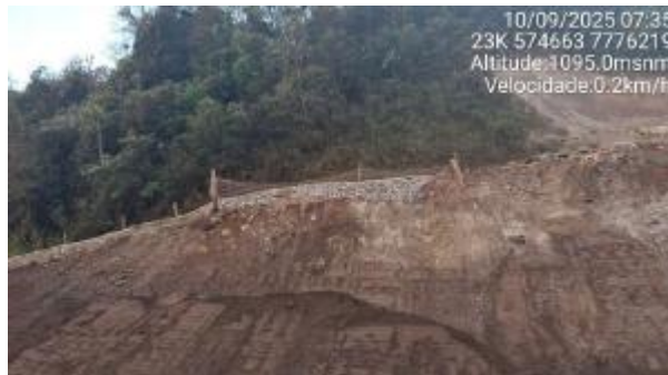
Foto 6-14 - Reconstituição da parede do canal de contorno em pedra argamassada.
