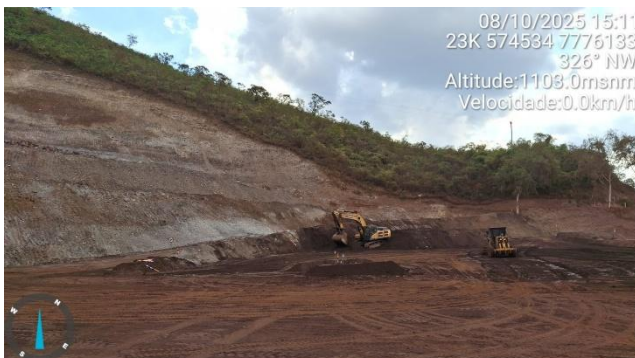
Foto 6-4 - Remoção do rejeito do reservatório – Etapa 1 – Fase 4A.
