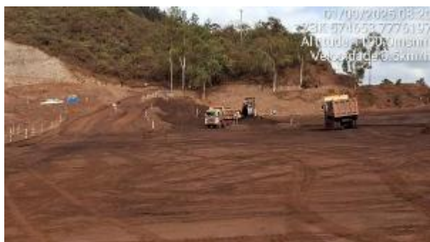
Foto 6-7 - Remoção do maciço do 8º alteamento – Etapa 1 – Fase 4B.
