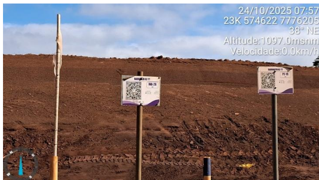
Foto 6.30 – Rebaixamento da instrumentação instalada no reservatório (INA-26 e PZ-19).
