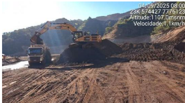
Foto 6-2 - Remoção do rejeito do reservatório – Etapa 1 – Fase 4A.
