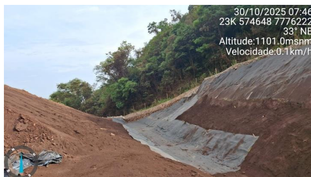
Foto 6.35 – Revestimento do canal de conexão ao extravasor de emergência.
