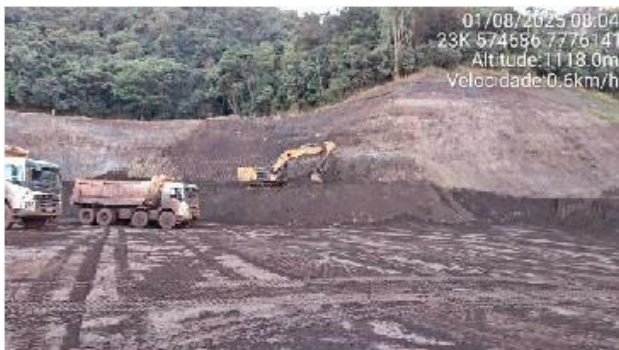
Foto 6-1 - Remoção do rejeito do reservatório – Etapa 1 – Fase 4A.
