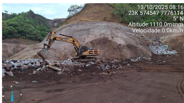
Foto 6.22 - Reposicionamento de blocos na região dos talvegues próximos à margem esquerda.
