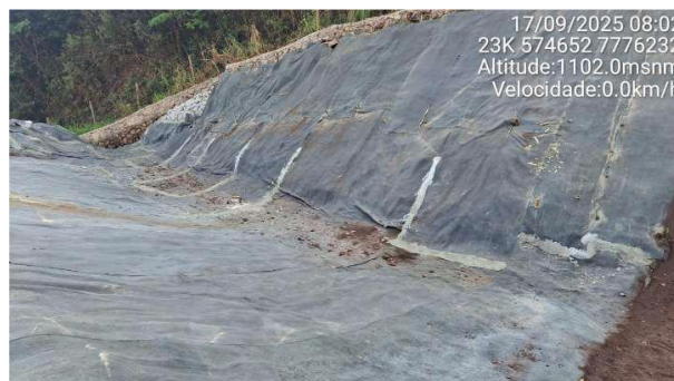
Foto 6-16 - Aplicação de manta cimentícia em parte do canal de aproximação.
