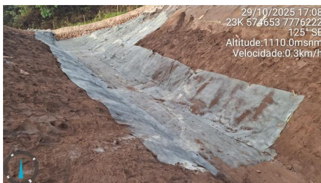
Foto 6.34 – Revestimento do canal de conexão ao extravasor de emergência.
