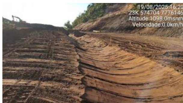
Foto 6-6 - Execução do canal de aproximação do extravasor de emergência – Etapa 1 – Fase 4B.
