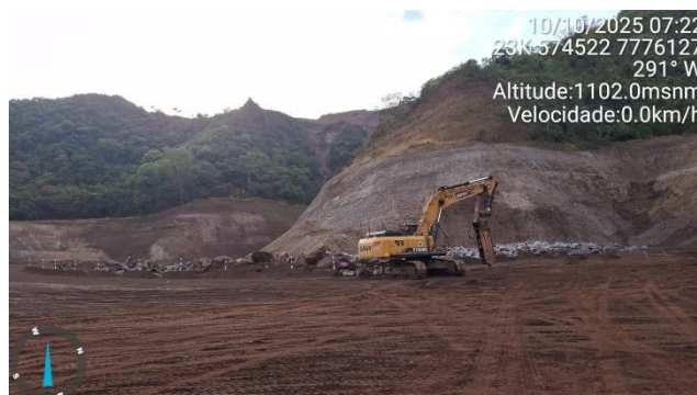
Foto 6.21 - Cominuição de blocos na região dos talvegues próximos à margem esquerda.
