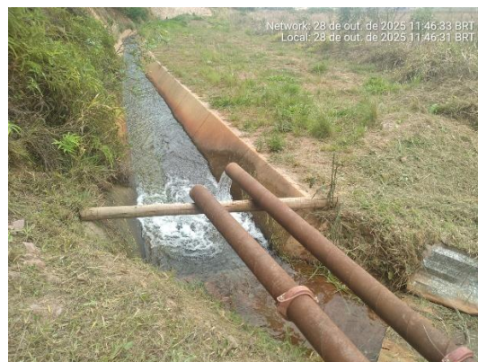
Foto 5-4 – Vista do direcionamento do fluxo dos poços para o extravasor da Barragem B1A Emicon.
