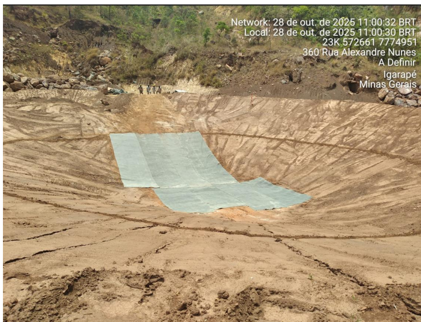
Figura 5.8 - Sump sendo coberto com manta cimentícia
