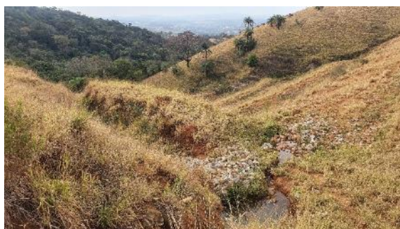
Figura 3-24: Processo erosivo incipiente, do tipo laminar, na área do aterro da antiga MMX (leste da ADA). Coordenadas: 576154.00 m E; e 7776942.00 m N. Ponto 3.
