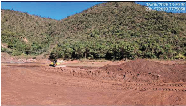
Foto 6.1.1 - Atividade de movimentação de rejeito no interior do reservatório referente à Etapa 1 – 16/06/26.
