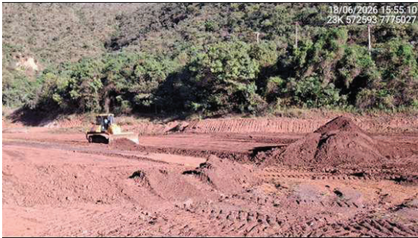
Foto 6.1.3 - Atividade de movimentação de rejeito no interior do reservatório referente à Etapa 1 – 18/06/26.
