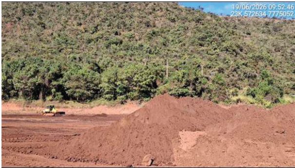
Foto 6.1.4 - Atividade de movimentação de rejeito no interior do reservatório referente à Etapa 1 – 19/06/26.
