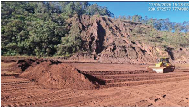
Foto 6.1.2 - Atividade de movimentação de rejeito no interior do reservatório referente à Etapa 1 – 17/06/26.
