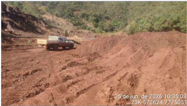
Foto 6.1.5 - Atividade de movimentação de rejeito no interior do reservatório referente à Etapa 1 – 25/06/26.
