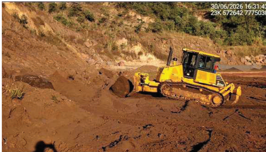
Foto 6.1.7 - Atividade de movimentação de rejeito no interior do reservatório referente à Etapa 1 – 30/06/26.
