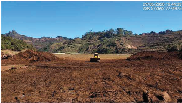
Foto 6.1.6 - Atividade de movimentação de rejeito no interior do reservatório referente à Etapa 1 – 29/06/26.
