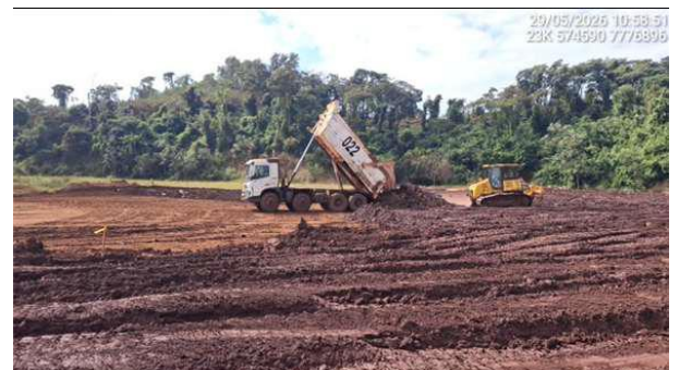
Foto 6-12 - Atividades de lançamento e espalhamento de rejeito filtrado.
