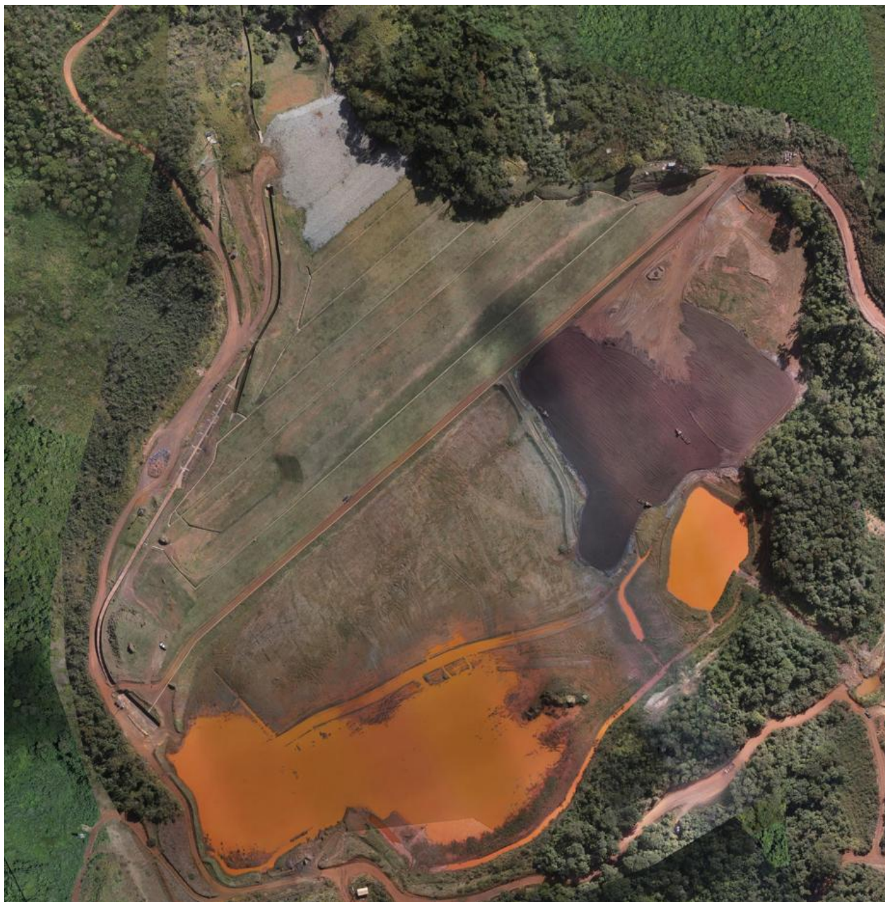
Figura 4-2 – Imagem da Barragem B1-Auxiliar – Mina Tico-Tico. (Fonte: Ortofoto MMI – Junho/2026).
