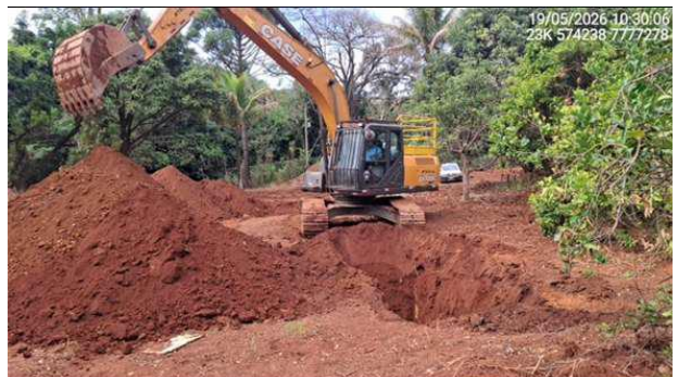
Foto 6-10 - Realização das aberturas das trincheiras de inspeção.
