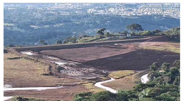
Foto 6-13 - Atividades de lançamento e espalhamento de rejeito filtrado.
