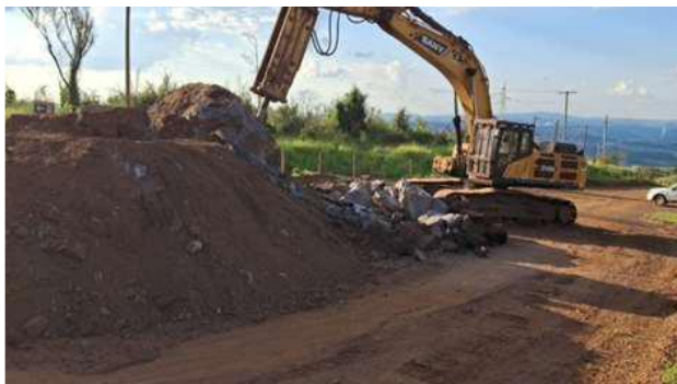
Foto 6-1 - Desmonte de matacão na ombreira esquerda – 22/04/26.
