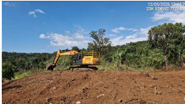
Foto 6-6 - Limpeza superficial destinada à construção dos sumps 8A e 8B.
