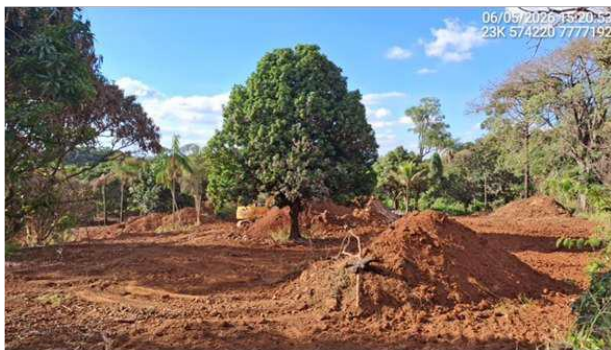
Foto 6-5 - Limpeza superficial destinada à construção dos sumps 8A e 8B.
