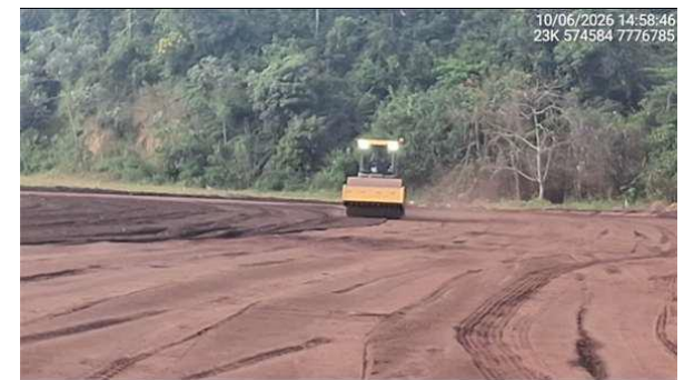
Foto 6-14 - Atividades de lançamento e espalhamento de rejeito filtrado.
