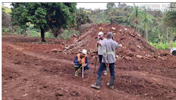
Foto 6-7 - Levantamento cadastral na área dos sumps 08A e 08B.
