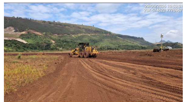
Foto 6-11 - Atividades de lançamento e espalhamento de rejeito filtrado.
