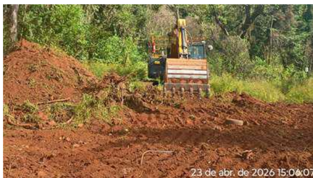
Foto 6-3 - Limpeza superficial destinada à construção dos sumps 8A e 8B.
