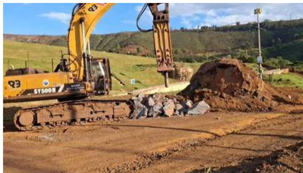
Foto 6-2 - Desmonte de matacão na ombreira esquerda – 22/04/26.
