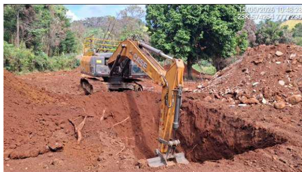
Foto 6-9 - Realização das aberturas das trincheiras de inspeção.
