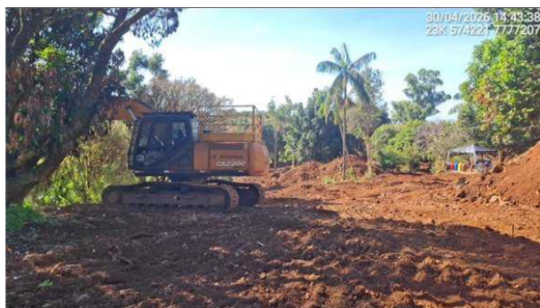
Foto 6-4 - Limpeza superficial destinada à construção dos sumps 8A e 8B.
