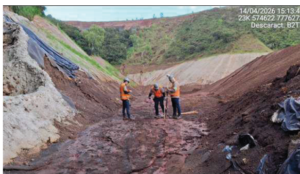
Foto 6.19 - Execução de levantamento topográfico para marcação de greide e controle de cotas na saída do canal (Abril/26).
