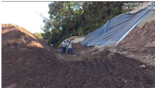
Foto 6.25 - Adequação geométrica do canal de emboque do extravasor (Maio/26).
