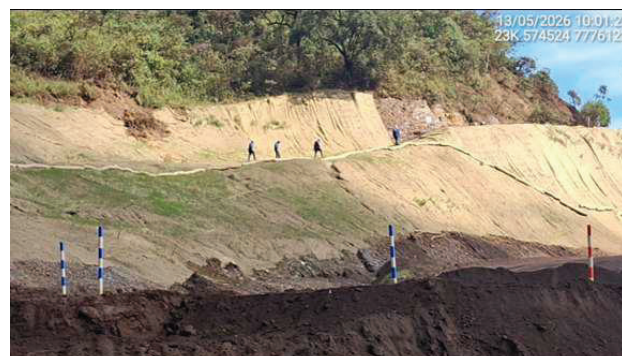
Foto 6.34 – Aplicação de biomanta e hidrossemeadura nos taludes expostos da encosta (Maio/26).
