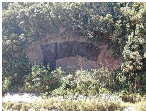
Foto 5.10 - Situação atual pós retirada do material solto na encosta O.D.
