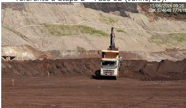
Foto 6.53 - Remoção do rejeito do reservatório referente à Etapa 2 – Fase 6B (Junho/26).
