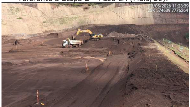
Foto 6.7 - Remoção do rejeito do reservatório referente à Etapa 2 – Fase 6A (Maio/26).
