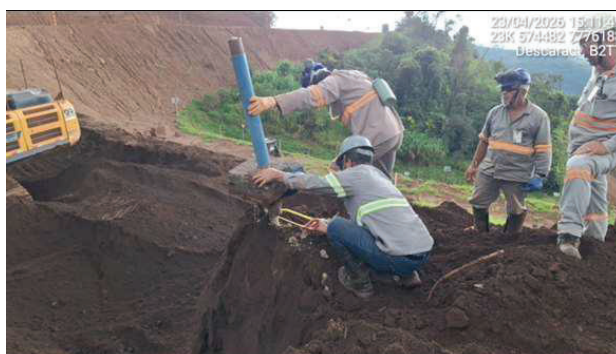
Foto 6.22 - Rebaixamento da instrumentação instalada na região do reservatório (Abril/26).
