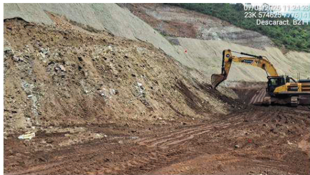
Foto 6.10 - Remoção de camada de rejeito até o contato com o terreno natural (Abril/26).
