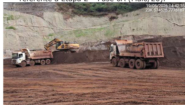
Foto 6.8 - Remoção do rejeito do reservatório referente à Etapa 2 – Fase 6A (Maio/26).
