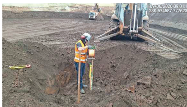
Foto 6.38 - Atividades de rebaixamento dos instrumentos no interior do reservatório (Junho/26).
