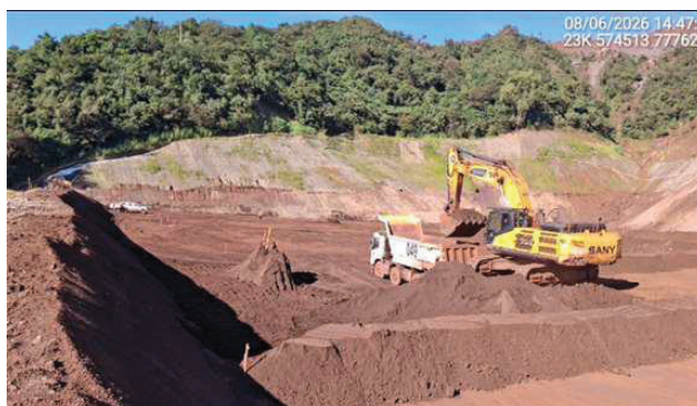
Foto 6.52 - Remoção do rejeito do reservatório referente à Etapa 2 – Fase 6B (Junho/26).
