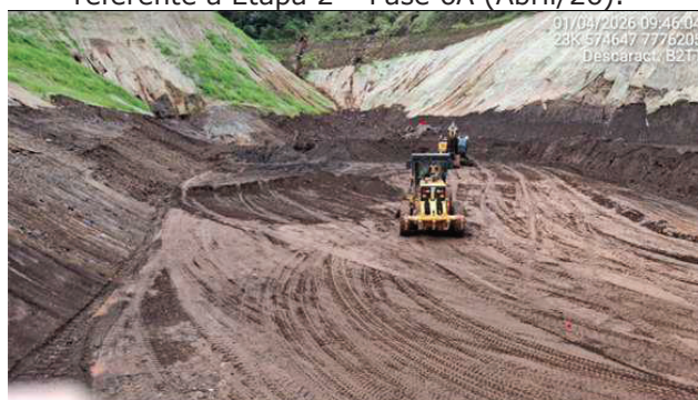
Foto 6.4 - Remoção do rejeito do reservatório referente à Etapa 2 – Fase 6A (Abril/26).
