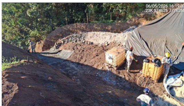
Foto 6.27 - Adequação geométrica do canal de emboque do extravasor (Maio/26).
