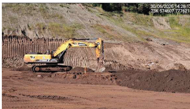
Foto 6.56 - Remoção do rejeito do reservatório referente à Etapa 3 – Fase 7A.
