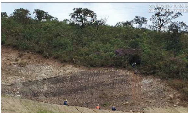
Foto 6.39 – Aplicação de geocélulas nas encostas do reservatório, na margem esquerda (Maio/26).
