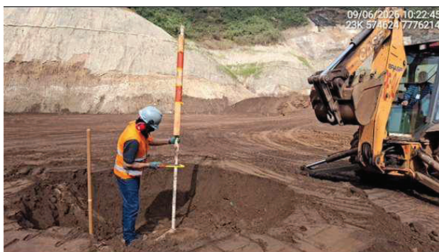
Foto 6.37 - Atividades de rebaixamento dos instrumentos no interior do reservatório (Junho/26).
