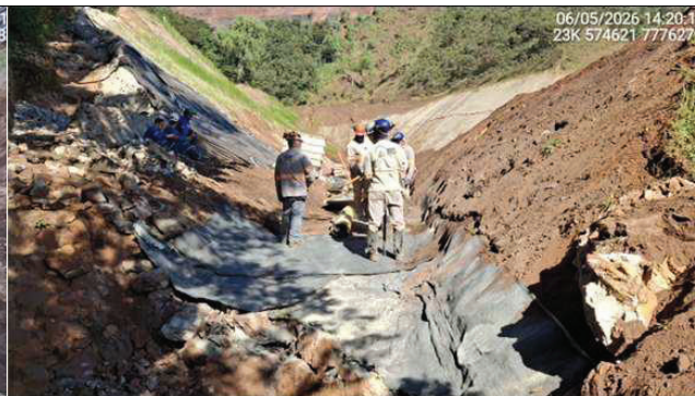
Foto 6.26 - Adequação geométrica do canal de emboque do extravasor (Maio/26).
