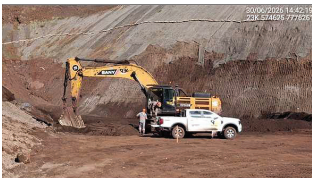
Foto 6.55 - Remoção do rejeito do reservatório referente à Etapa 3 – Fase 7A.
