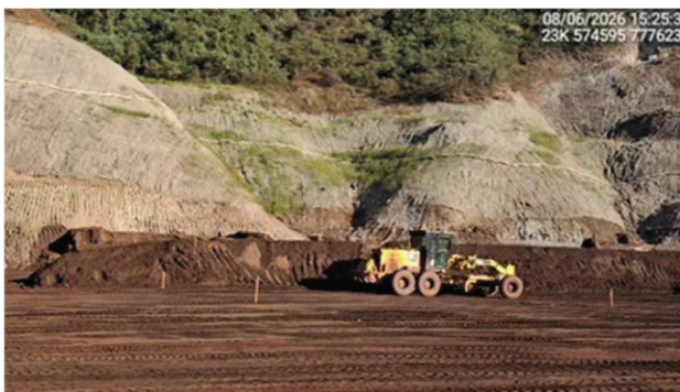
Foto 6.49 - Melhorias e manutenção das vias de acesso ao reservatório e da área de carregamento (Junho/26).
