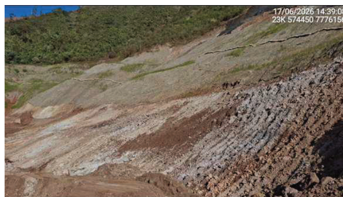
Foto 6.35 - Aplicação de biomanta e hidrossemeadura nos taludes expostos da encosta (Junho/26).
