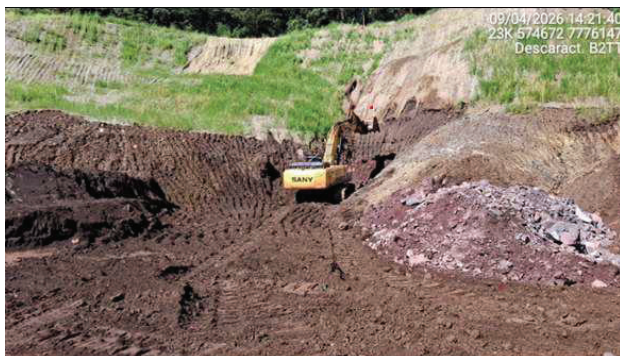
Foto 6.11 - Remoção de camada de rejeito até o contato com o terreno natural (Abril/26).
