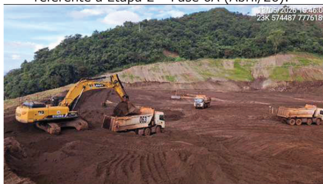
Foto 6.6 - Remoção do rejeito do reservatório referente à Etapa 2 – Fase 6A (Maio/26).
