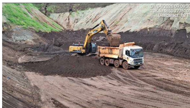
Foto 6.2 - Remoção do rejeito do reservatório referente à Etapa 2 – Fase 6A (Abril/26).
