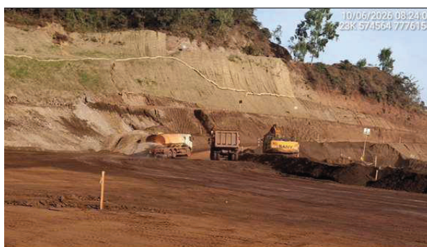
Figura 6.2 - Umectação de vias e da região do reservatório.
