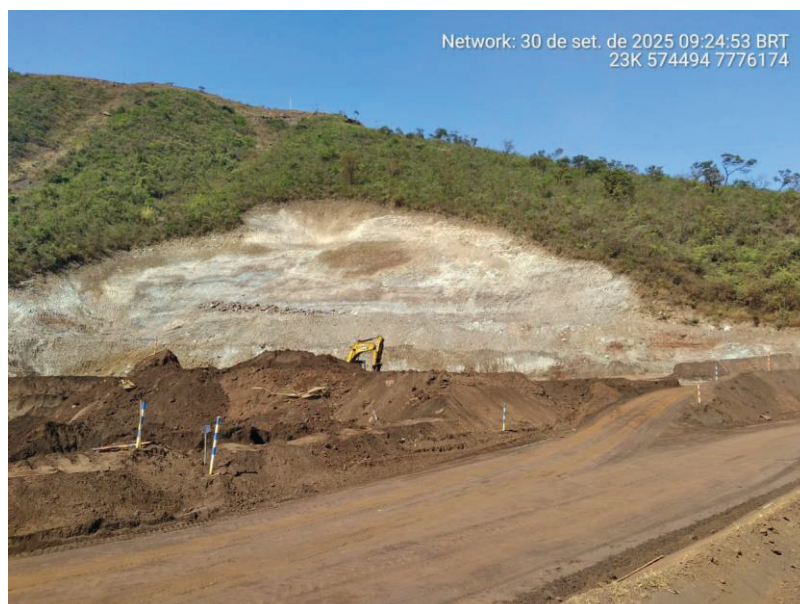
Foto 5.6 - Ombreira Esquerda regularizada com material superficial removido
