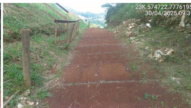
Foto 5.8 – Grades metálicas instaladas sobre o canal extravasor de emergência.
