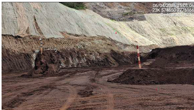
Foto 6.9 - Remoção de camada de rejeito até o contato com o terreno natural (Abril/26).
