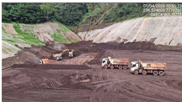
Foto 6.1 - Remoção do rejeito do reservatório referente à Etapa 2 – Fase 6A (Abril/26).
