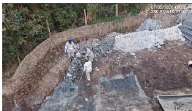
Foto 6.29 - Execução da parede do canal de ombreira (Maio/26).
