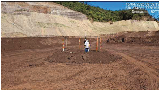
Foto 6.17 - Após a conclusão do rebaixamento da instrumentação existente no reservatório, a equipe de topografia realizou o levantamento das cotas de topo dos instrumentos (Abril/26).
