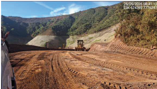
Foto 6.47 - Melhorias e manutenção das vias de acesso ao reservatório e da área de carregamento (Maio/26).
