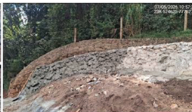
Foto 6.30 - Execução da parede do canal de ombreira (Maio/26).
