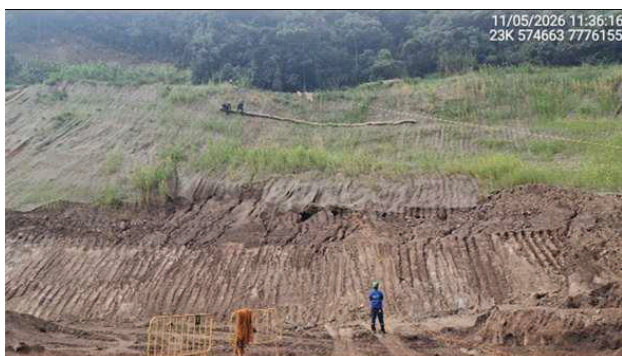
Foto 6.33 – Aplicação de biomanta e hidrossemeadura nos taludes expostos da encosta (Maio/26).
