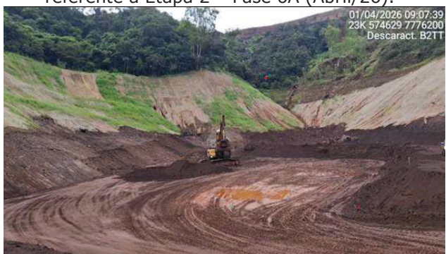
Foto 6.3 - Remoção do rejeito do reservatório referente à Etapa 2 – Fase 6A (Abril/26).
