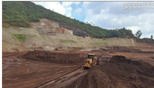
Foto 6.48 - Melhorias e manutenção das vias de acesso ao reservatório e da área de carregamento (Maio/26).
