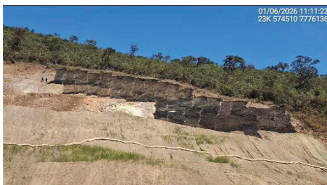
Foto 6.41 - Aplicação de geocélulas nas encostas do reservatório, na margem esquerda (Junho/26).
