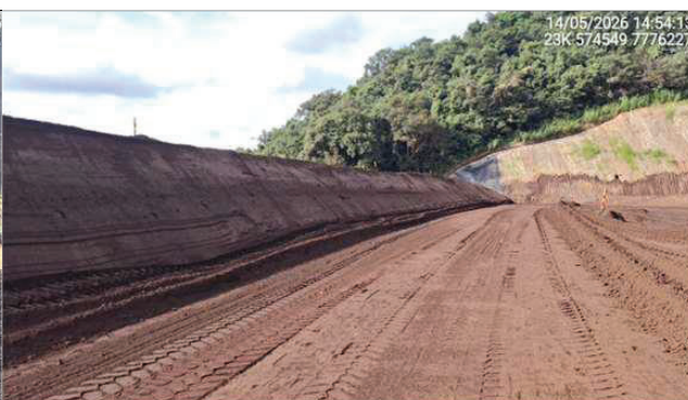
Foto 6.24 - Rebaixamento controlado do maciço (Maio/26).
