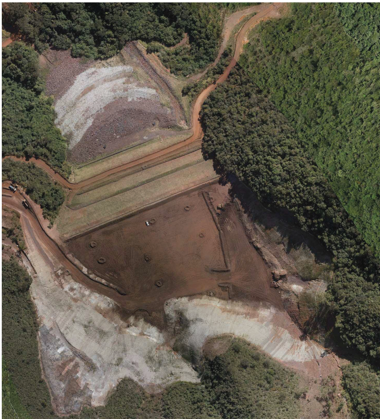
Figura 6.7 – Imagem aérea da Barragem B2 – Mina Tico-Tico. (Ortofoto 01/07/26).
