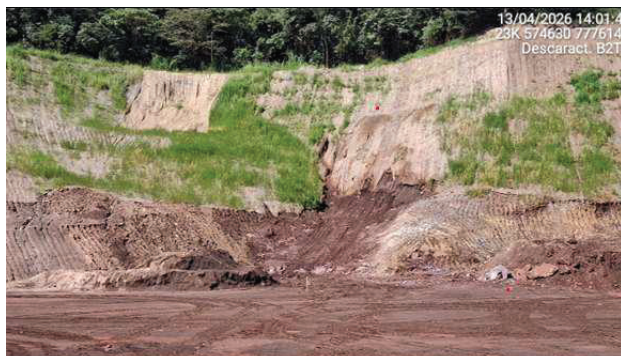
Foto 6.12 - Remoção de camada de rejeito até o contato com o terreno natural (Abril/26).
