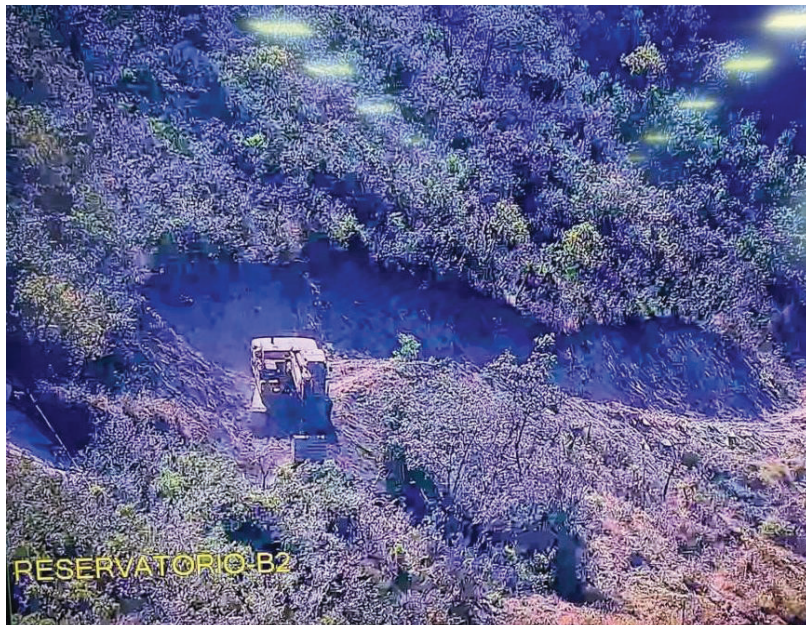
Foto 5.5 – Início da regularização na encosta ombreira esquerda.
