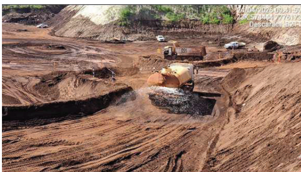
Foto 6.13 - Umectação de vias e da região do reservatório (Abril/26).
