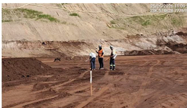
Foto 6.43 – Execução de levantamento Topográfico (Maio/26).
