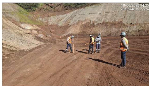
Foto 6.46 - Execução de levantamento topográfico (Junho/26).
