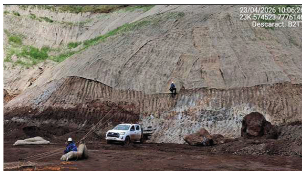
Foto 6.21 - Aplicação de biomanta e hidrossemeadura na região exposta da encosta (Abril/26).
