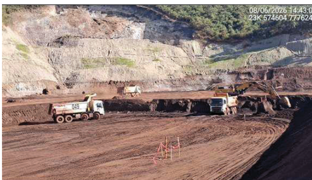
Foto 6.51 - Remoção do rejeito do reservatório referente à Etapa 2 – Fase 6B (Junho/26).
