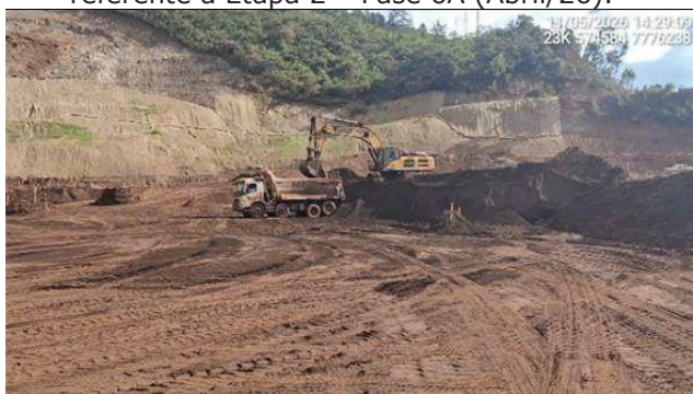
Foto 6.5 - Remoção do rejeito do reservatório referente à Etapa 2 – Fase 6A (Maio/26).
