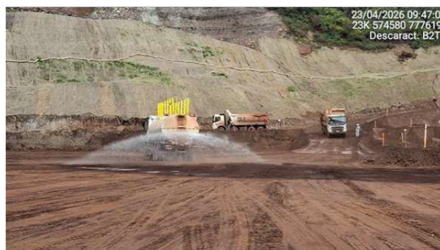
Foto 6.14 - Umectação de vias e da região do reservatório (Abril/26).
