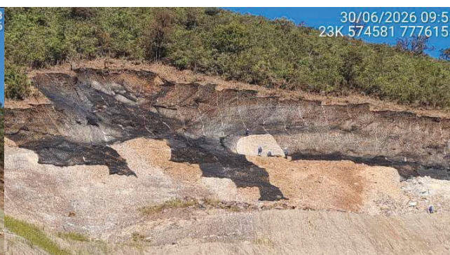
Foto 6.42 - Aplicação de geocélulas nas encostas do reservatório, na margem esquerda (Junho/26).
