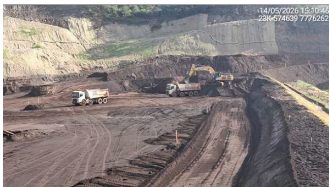
Foto 6.23 - Rebaixamento controlado do maciço (Maio/26).
