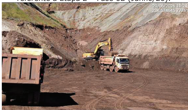
Foto 6.54 - Remoção do rejeito do reservatório referente à Etapa 2 – Fase 6B (Junho/26).
