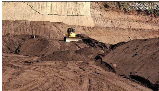
Foto 6.32 – Adequação de acessos operacionais nas ombreiras esquerda e jusante do maciço (Maio/26).
