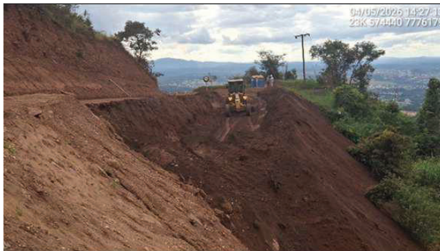
Foto 6.31 – Adequação de acessos operacionais nas ombreiras esquerda e jusante do maciço (Maio/26).
