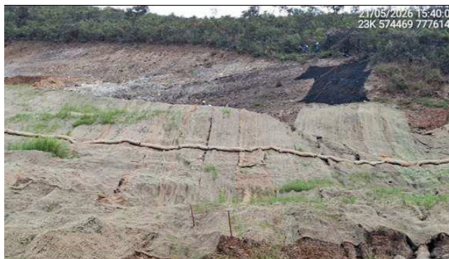
Foto 6.40 – Aplicação de geocélulas nas encostas do reservatório, na margem esquerda (Maio/26).
