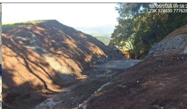
Foto 6.28 - Adequação geométrica do canal de emboque do extravasor (Maio/26).
