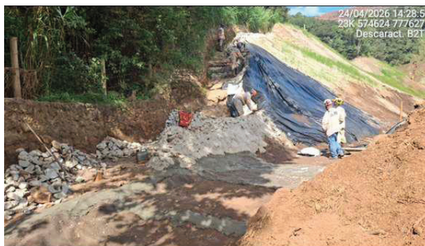
Foto 6.20 - Recomposição de trecho da parede do canal de contorno em pedra argamassada. (Abril/26).
