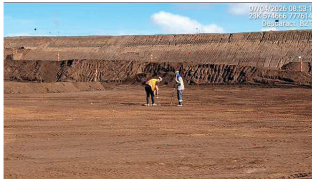
Foto 6.18 - Execução de levantamento topográfico para marcação de greide e controle de cotas no reservatório referente à Etapa 2 - Fase 6A (Abril/26).
