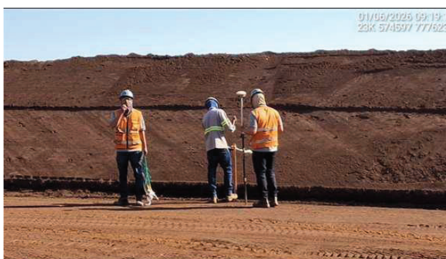
Foto 6.45 - Execução de levantamento topográfico (Junho/26).
